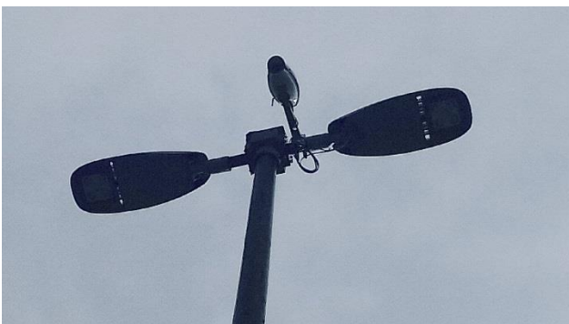
Figura 2 – Palo con i due corpi illuminanti e una delle telecamere Smart Eye
