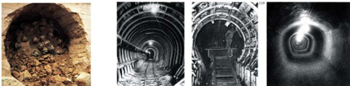
Figura 2. Immagini della costruzione delle gallerie dell'acquedotto del Peschiera scavate nella roccia.
