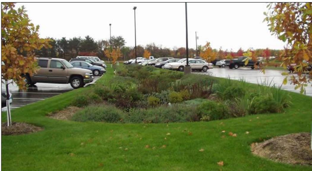
Figura 5.9: Canale inerbito realizzato in un parcheggio [<http://www.minnehahacreek.org>]
