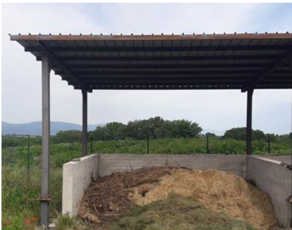
Figura 12: cumulo di matrici vegetali presso il sito di compostaggio di Vasanello
