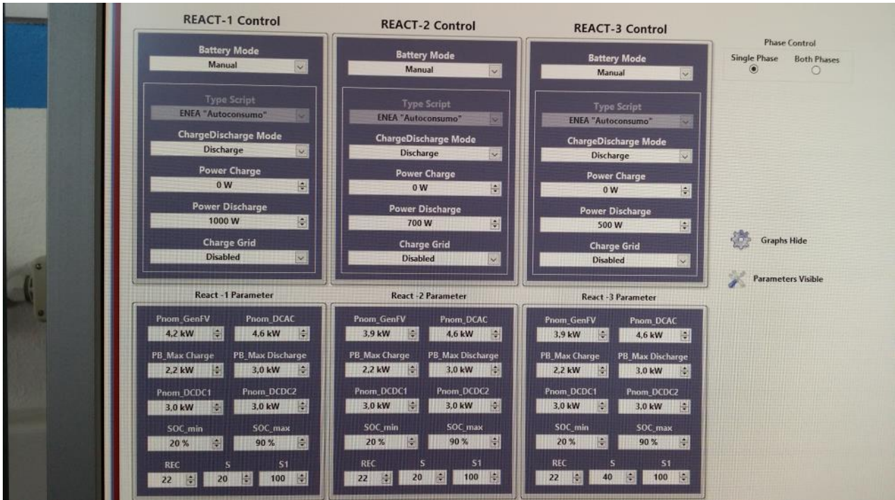
Figura 40. Schermata di Controllo della gestione Inverter
