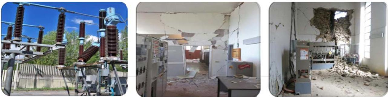
**Figura 5. Danni alla sezione alta tensione, AT indotti dal terremoto di Amatrice (Italia Centrale) del 24/08/2016: a) caduta dei sezionatori AT; b),c) danni al fabbricato della cabina primaria, e quadro di media tensione intatto (fotografie estratte da [4]).**
