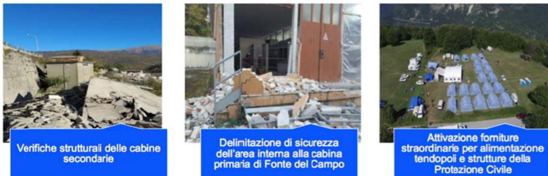
Figura 9. Operazioni nei primi giorni successivi all’evento: a) verifica strutturale delle cabine secondarie; b) delimitazioni di sicurezza nella cabina primaria di Fonte del Campo; c) attivazione fornitura elettrica per le tendopoli.
