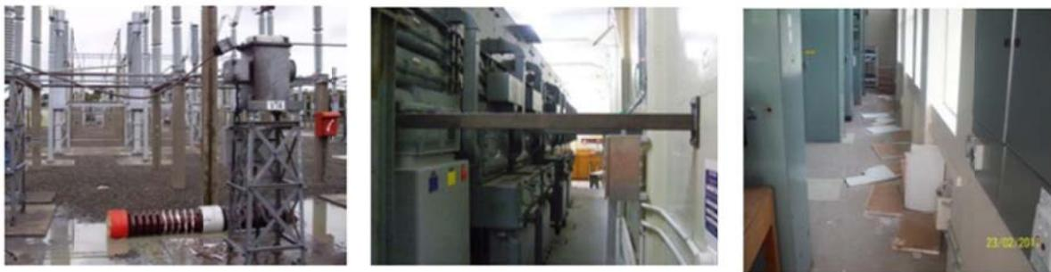
**Figura 18. Sottostazione di Bromley: a) trasformatore di tensione corrente a 220 kV, caduta b) Controventatura Bromley installata nella parte anteriore e posteriore dei pannelli del quadro elettrico; c) pannelli del controsoffitto dislocati nell'edificio di controllo e relè, (Foto gentilmente fornite da Transpower).**
