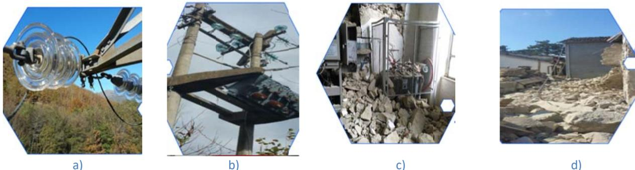
Figura 7. Danni alle linee MT e BT: a) sostegni sbandati e conduttori a terra; b) posti di trasformazione su palo PTP caduti dalle mensole; c) danni ai fabbricati delle cabine secondarie in muratura; d) linee aeree BT danneggiate dal collasso di edifici prospicienti (fotografie estratte da [4]).
