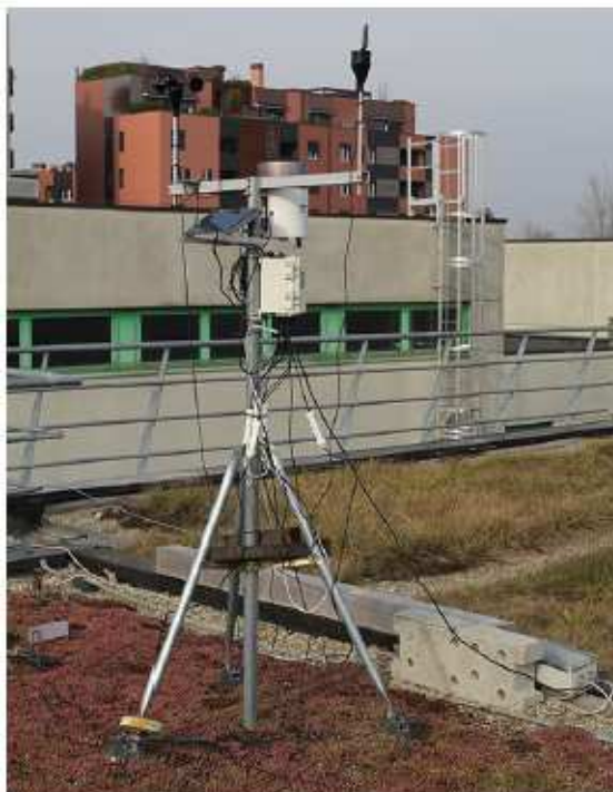
Figura 3.10: stazione meteorologica installata sulla copertura sperimentale
