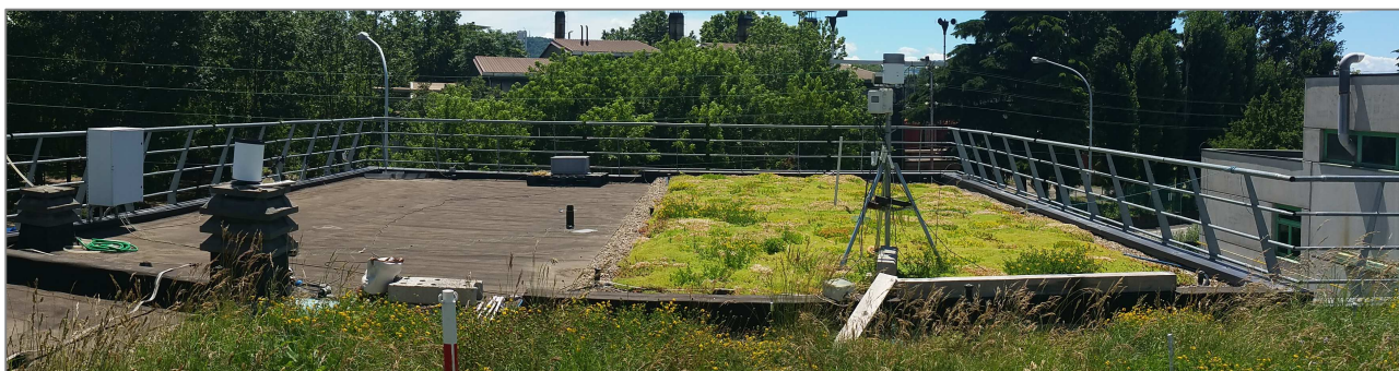
Figura 2.13: tetto verde sperimentale presso la Scuola di Ingegneria dell'Università di Bologna
