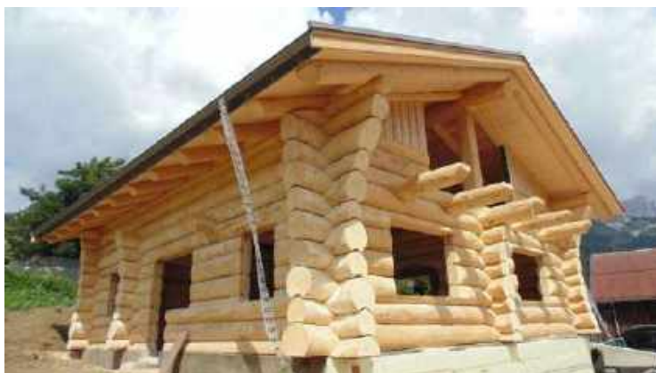
Figura 125. Esempio di abitazione realizzata con sistema Blockbau.
