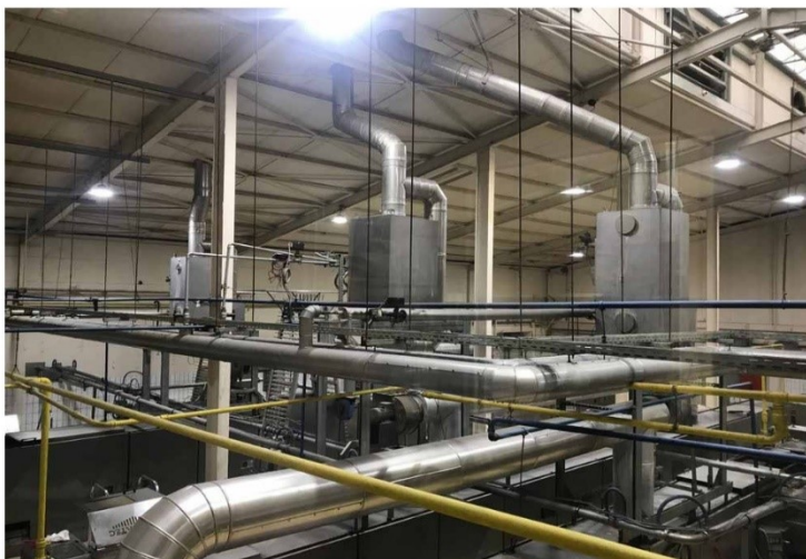
Il calore dei forni del produttore di cialde Wafels Mayer, viene raccolto in tubazioni e alimenta il sistema di teleriscaldamento del vicino villaggio di Verme (CO BVC-SA.21)
