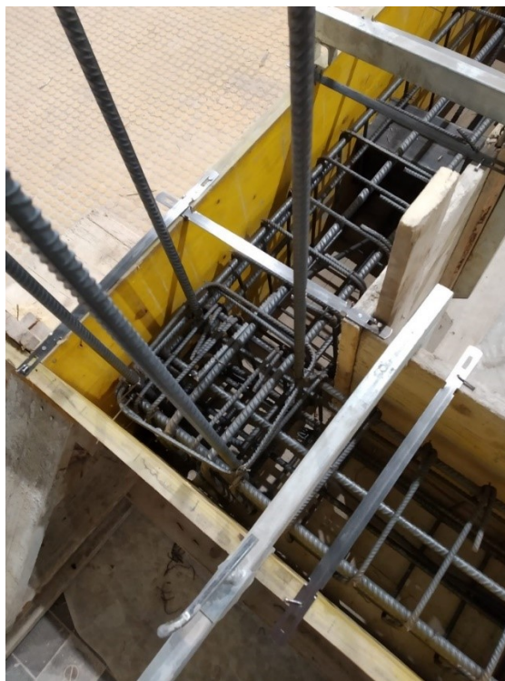
Figura 237. Realizzazione della trave di fondazione: vista del nodo trave-pilastro
