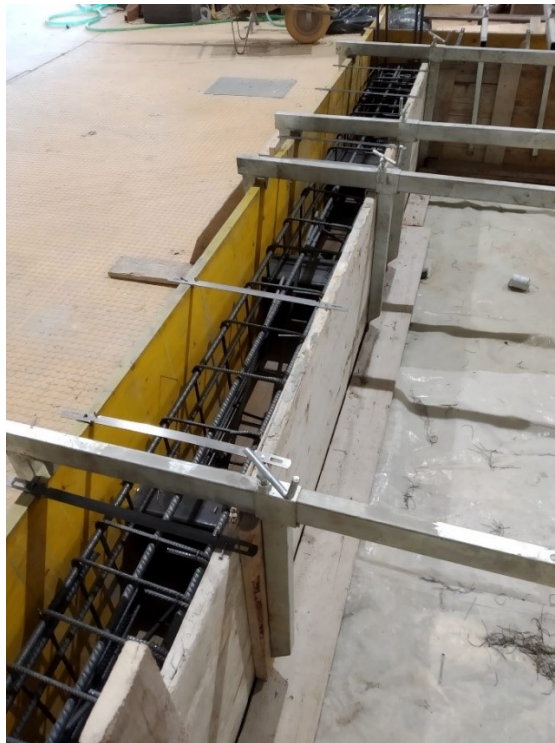
Figura 236. Realizzazione della trave di fondazione: vista dei ferri longitudinali e delle staffe
