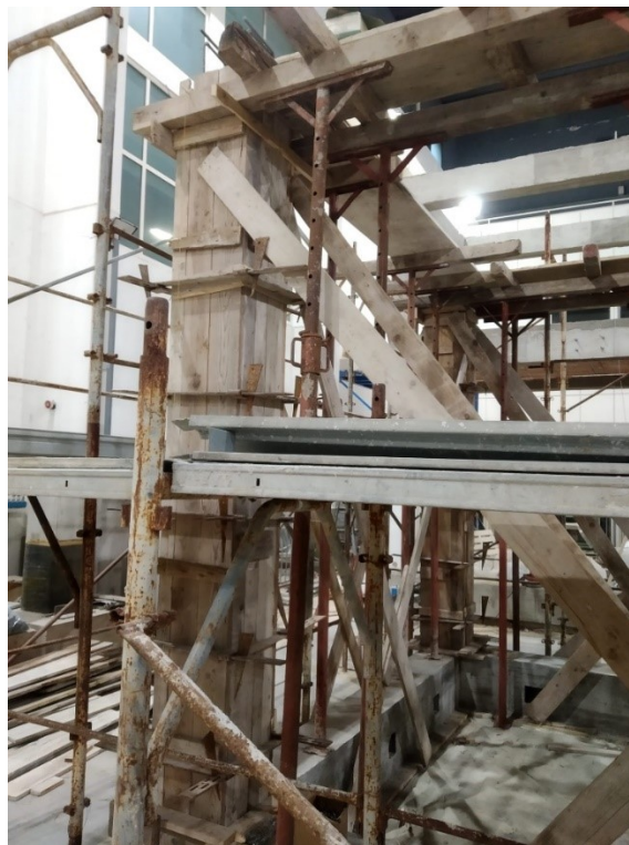
Figura 238. Realizzazione dei pilastri e del solaio: vista dei casseri dei pilastri
