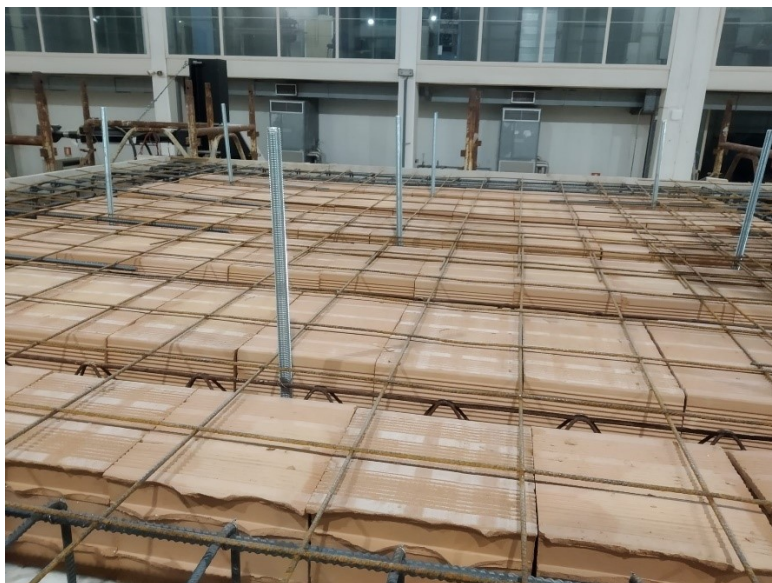
Figura 241. Realizzazione dei pilastri e del solaio: vista delle bare filettate che emergono dal solaio
