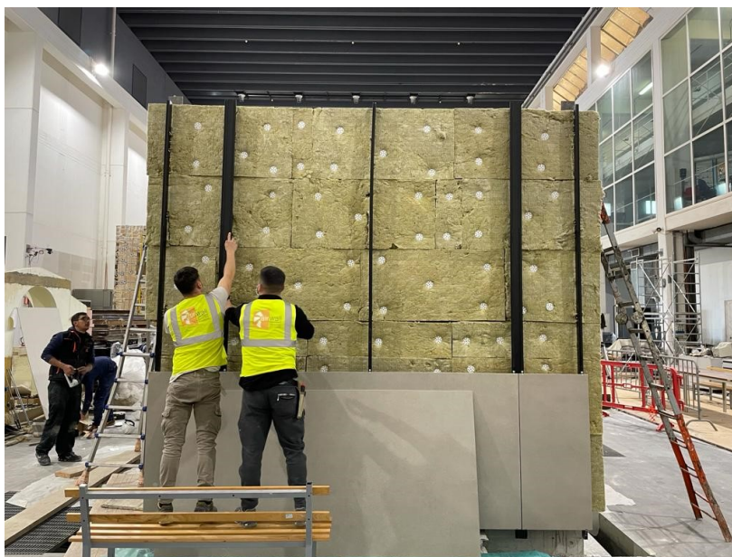
Figura 253. Parete ovest: posa dell'isolante e installazione delle lastre ceramiche di rivestimento
