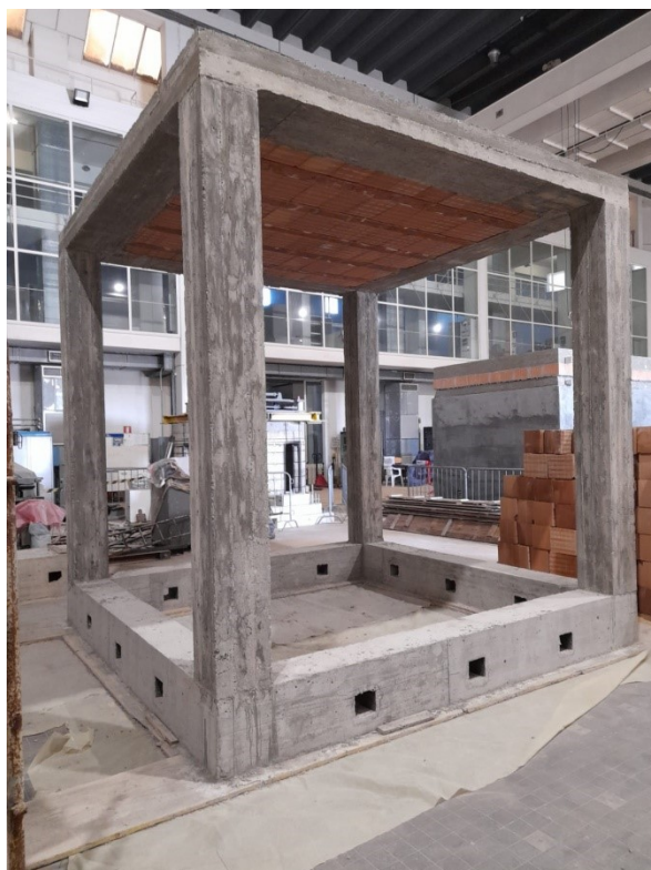
Figura 242. Manufatto in cemento armato
