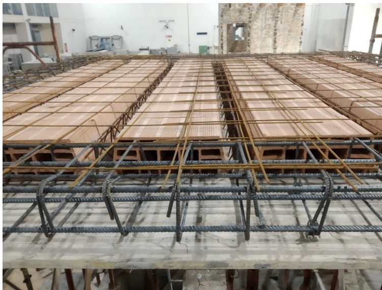
Figura 240. Realizzazione dei pilastri e del solaio: vista delle armature del solaio
