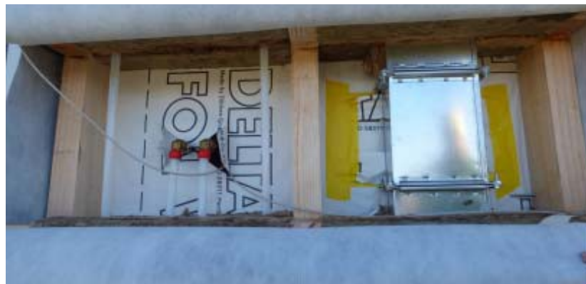
Figura 31. Progetto BERTIM – Installazione dei moduli in facciata
