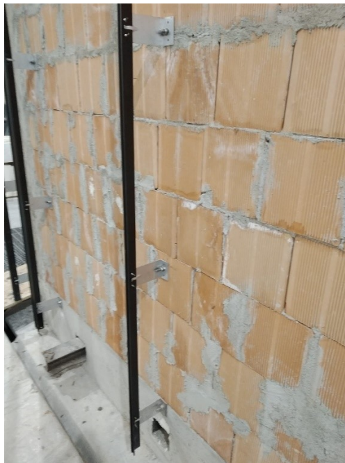
Figura 252. Parete ovest: ancoraggio dei profili metallici verticali
