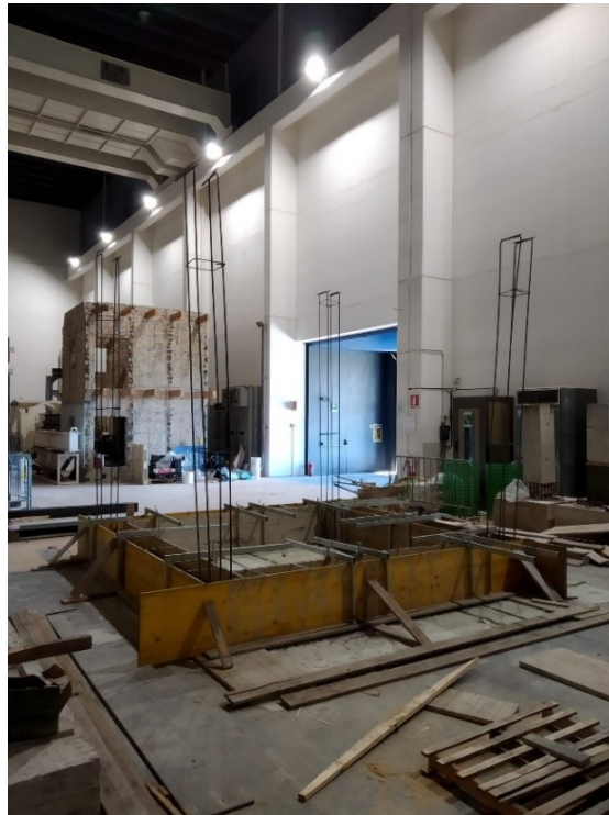
Figura 235. Realizzazione della trave di fondazione: vista dei ferri longitudinali dei pilastri
