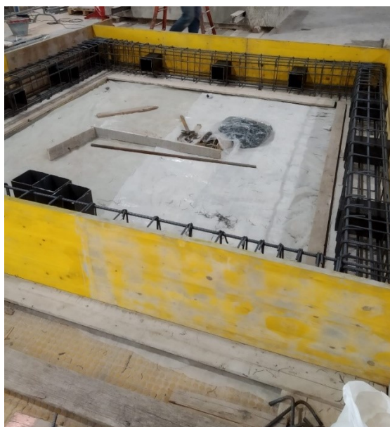
Figura 234. Realizzazione della trave di fondazione: casseri e ferri di armatura per la trave di fondazione
