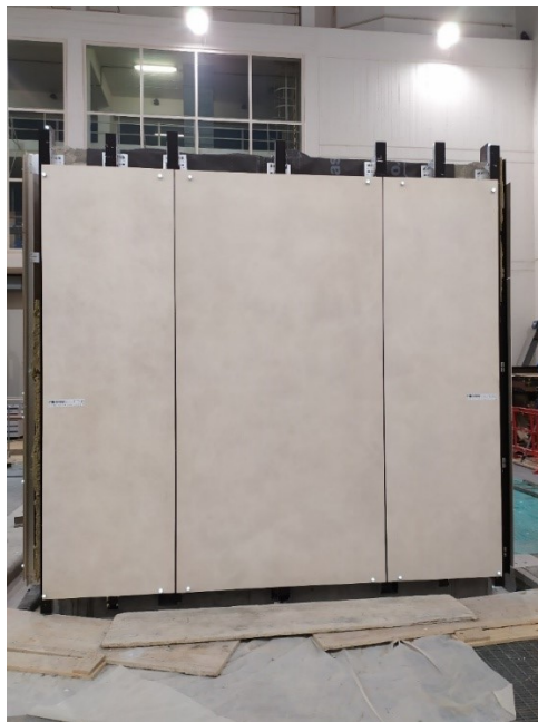
Figura 270. Parete nord: vista della parete finita
