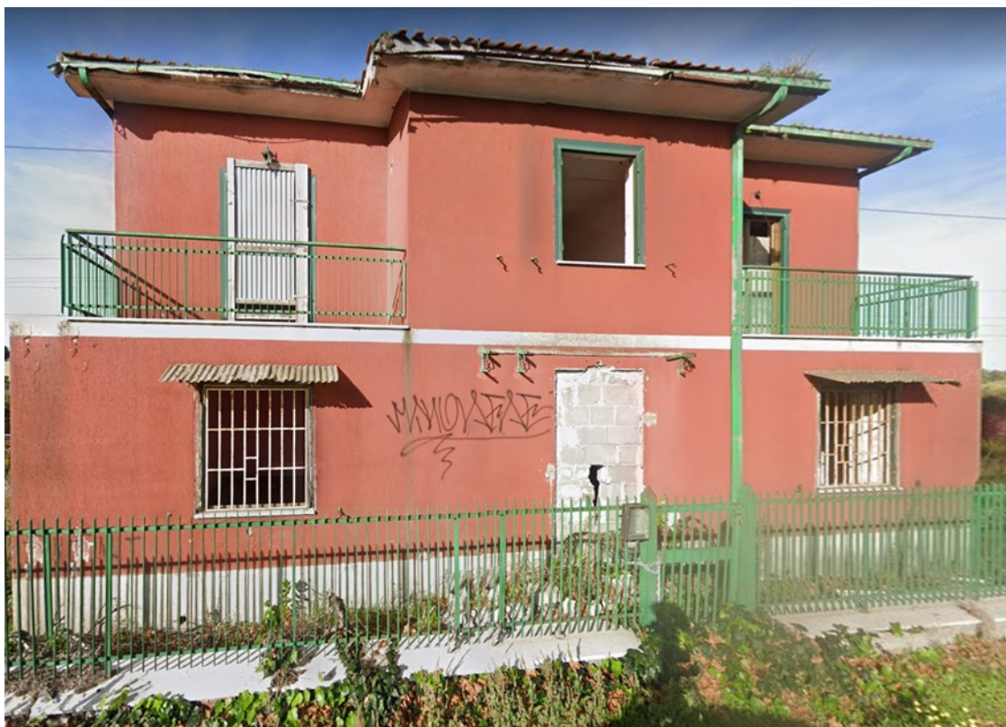
Figura 4 Edificio oggetto di monitoraggio (ante operam) – prospetto Est
