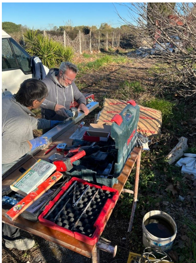
Figura 44 Taglio della sottostruttura metallica
