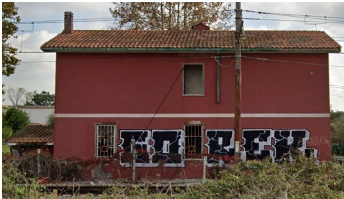
Figura 5 Edificio oggetto di monitoraggio – prospetto Ovest
