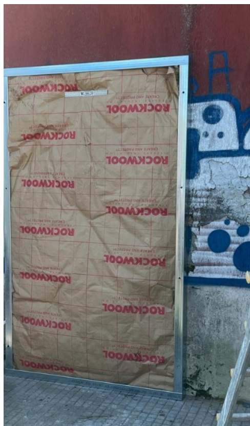
Figura 46 Inserimento materiale isolante
