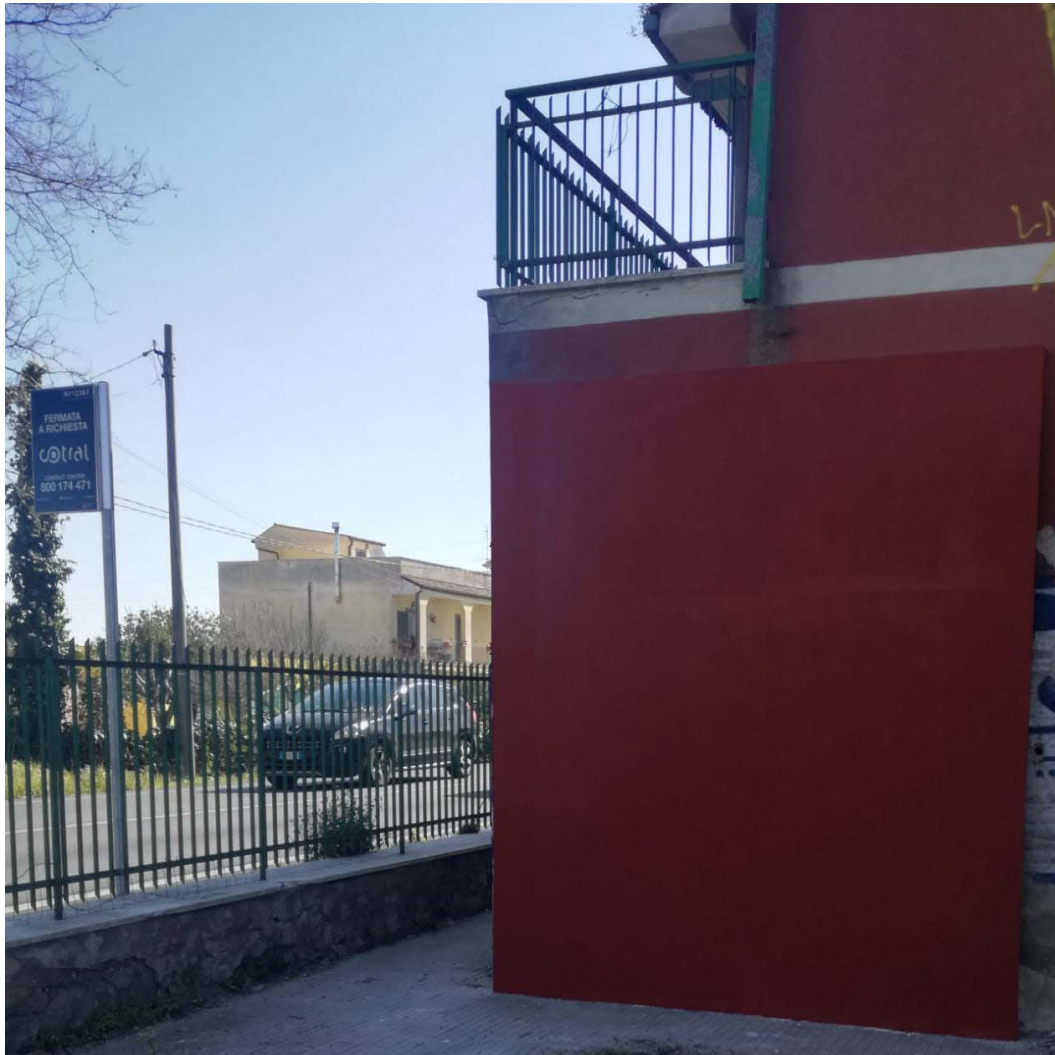
Figura 51 Componenti di isolamento rasati e tinteggiati
