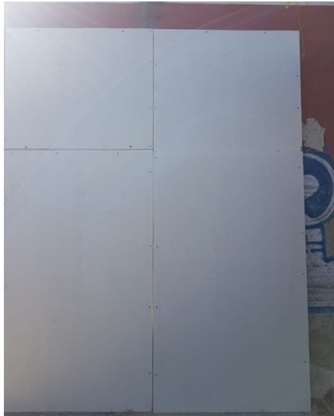
Figura 49 Applicazione delle lastre in calcio silicato
