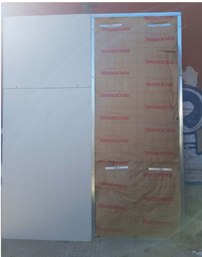
Figura 48 Accostamento dei componenti di isolamento
