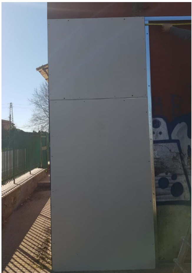
Figura 47 Pannellatura realizzata con lastre in calcio-silicato
