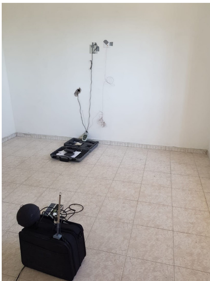
Figura 39 Installazione della piastra termoflussimetrica e del sensore di temperatura sul lato interno della parete esposta a nord
