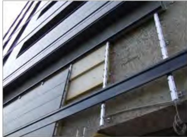
Particolare della facciata Est, vista della facciata ventilata in costruzione, montata con sistema Dalleria Tecnologie, modello "Venere Nascosto"
