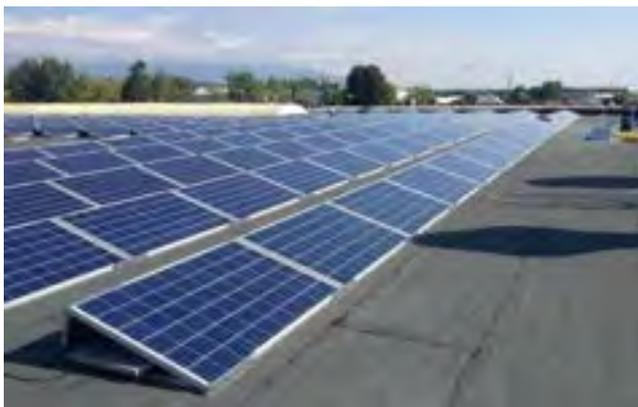
Figura 2. Esempio di impianto BAPV non integrato installato su copertura piana [Fonte: ECO-ROOF].
