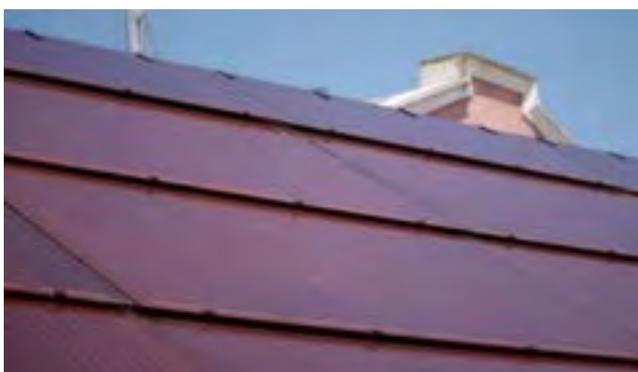
Figura 4. Esempio di impianto BIPV integrato su copertura inclinata [Fonte: EnergyGlass].
