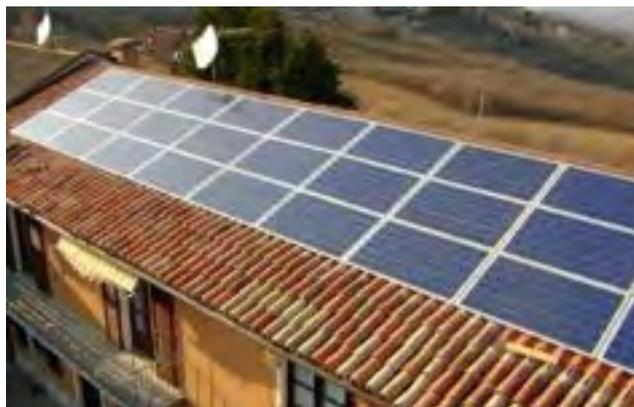
Figura 3. Esempio di impianto BAPV parzialmente integrato installato su copertura inclinata [Fonte: VGS Italia].
