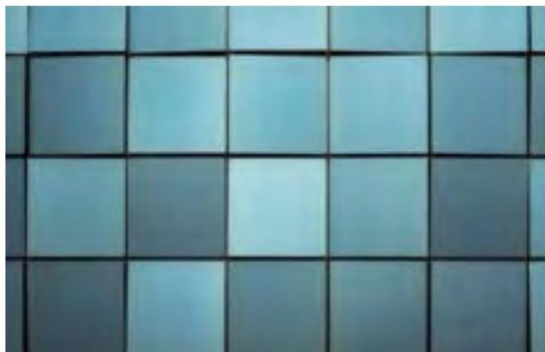
**Figura 38. I moduli con vetri Kromatix appaiono di una differente tonalità al variare dell'angolo di osservazione [Fonte: SWISSINSO].**
