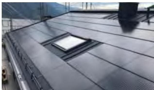
Figura 5. Esempio di impianto BIPV integrato su copertura inclinata [Fonte: SUNAGE].
