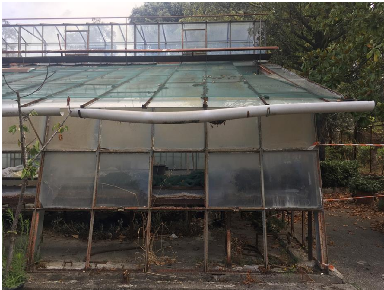
Figura 2.2.1. La serra oggetto dell'intervento prima dei lavori: dettaglio della falda sud.
