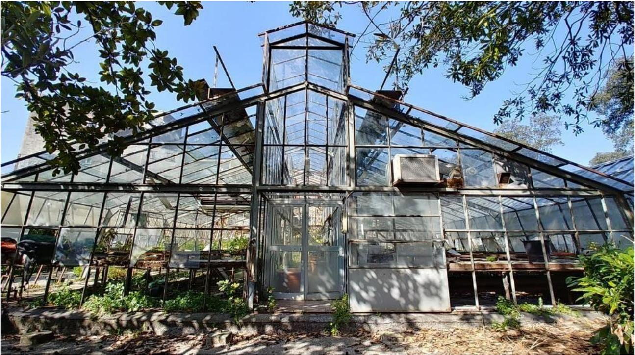
**Figura 53, Veduta dell'entrata della serra di "ex-Patologia", si nota lo stato di abbandono della stessa ed il danneggiamento della copertura vetrata in seguito ad eventi metereologici avversi.**
