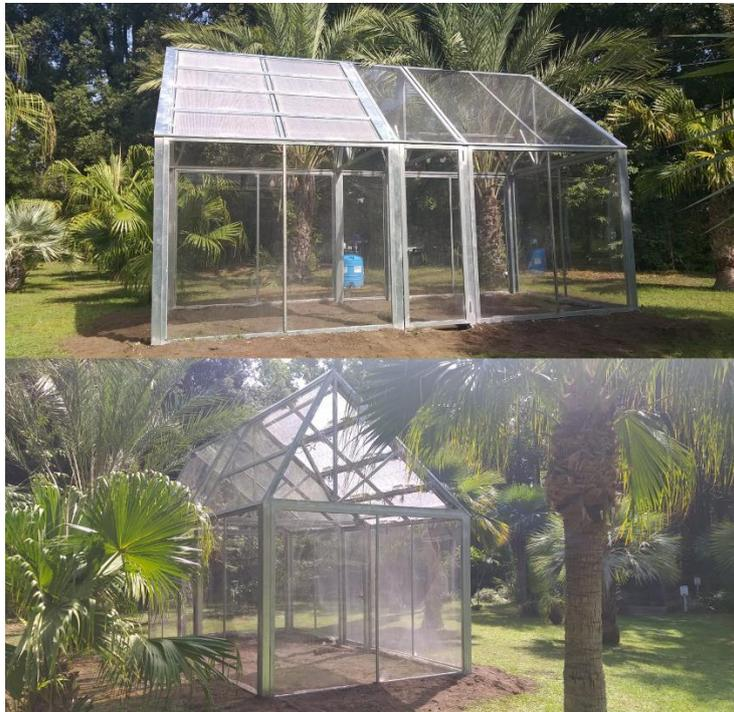
**Figura 40** Realizzazione della serra media con copertura di pannelli di policarbonato trasparente.
