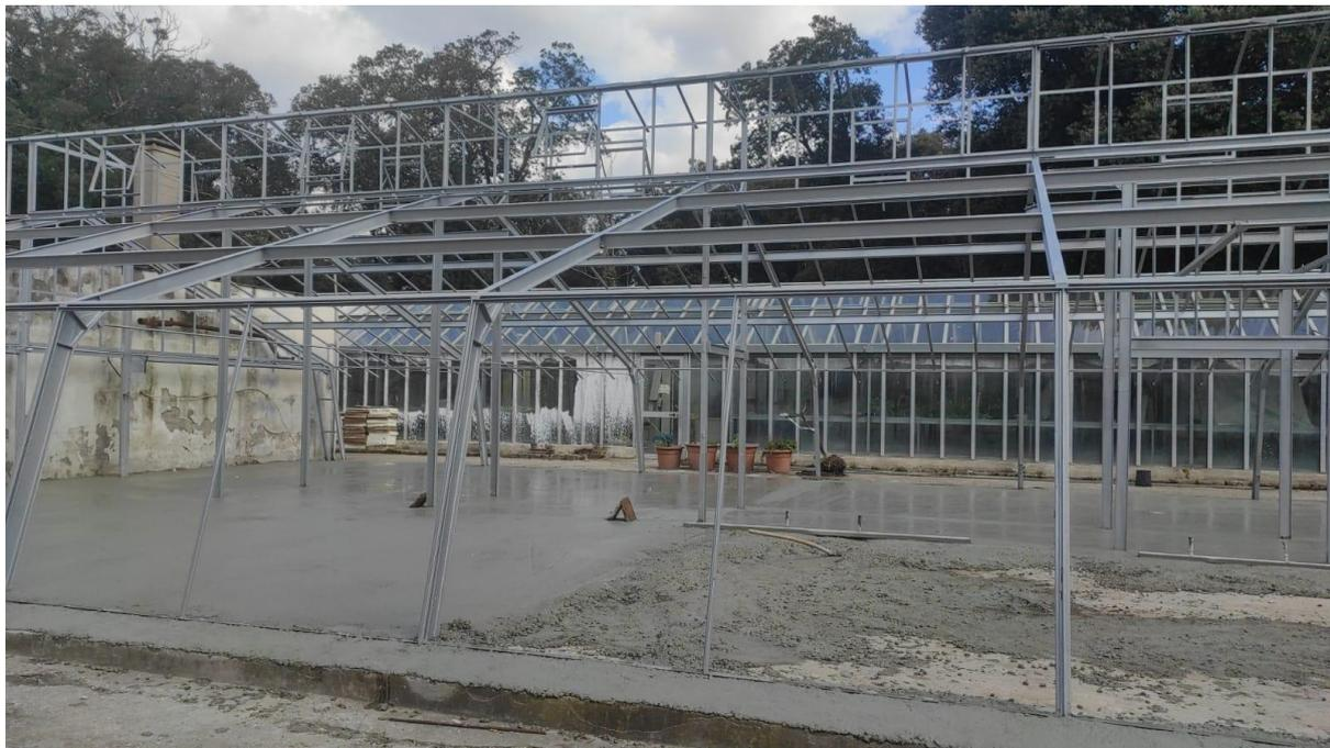
**Figura 7 Serra storica durante la messa in posa del massetto**
