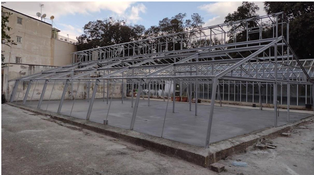
**Figura 8 Vista della serra storica dopo la messa a terra del massetto**
