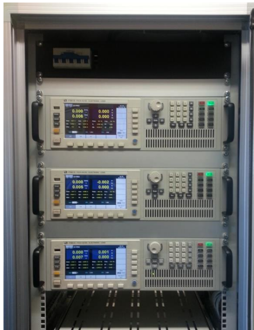
Figura 58: Installazione dei carichi elettronici DC/AC
