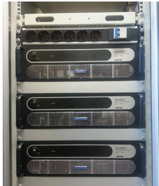
Figura 50: Simulatori di array fotovoltaici
