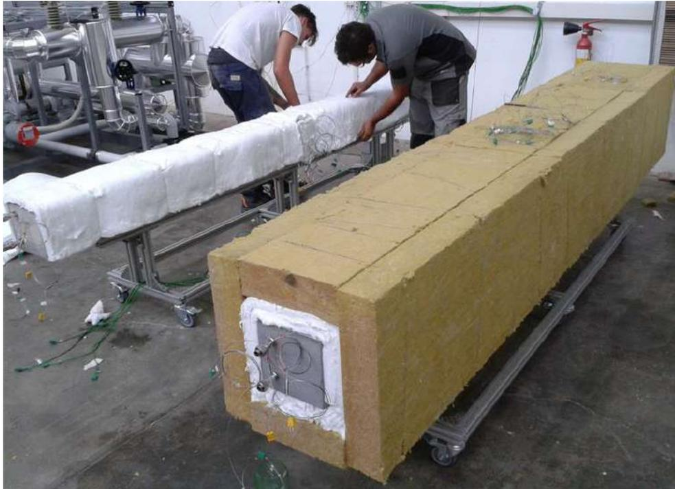
Figura 5: Coibentazione del modulo di accumulo.
