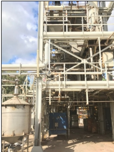
Figura 4.69 – Castelletto dell'impianto prima della rimozione di reattore e tramoggia.
