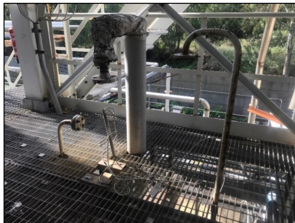
Figura 4.57 - Area dopo lo smontaggio del BA003.
