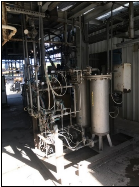
Figura 4.43 – PSA prima della rimozione
