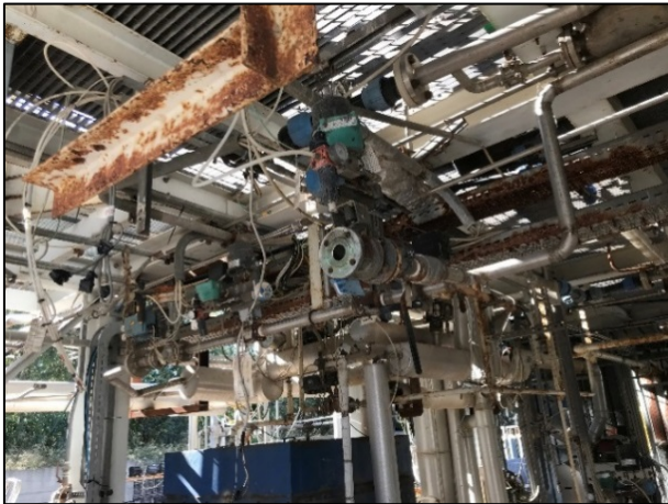
Figura 4.19 – Piano terra, prima della rimozione dell'ultima valvola di intercettazione pneumatica.
