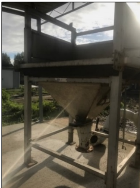
Figura 4.77 - Tramoggia di caricamento dopo la rimozione.
