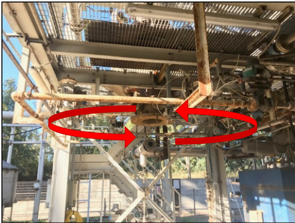
Figura 4.17 – Anello di alimentazione aria lampade.
