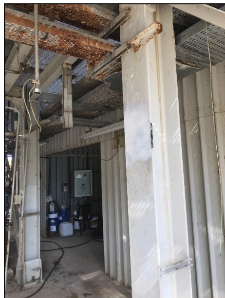
Figura 4.35 – Trave a seguito della rimozione della mensola.
