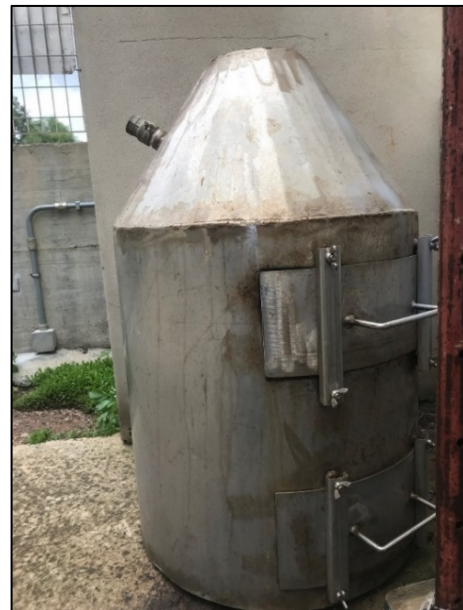
Figura 4.10 - Serbatoio di raccolta ceneri.
