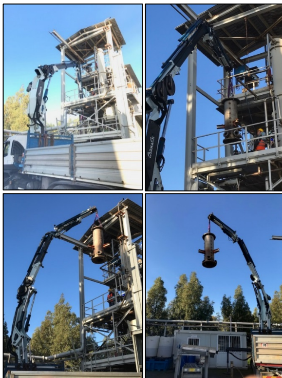
Figura 4.79 - Fasi di rimozione del reattore di gassificazione.
