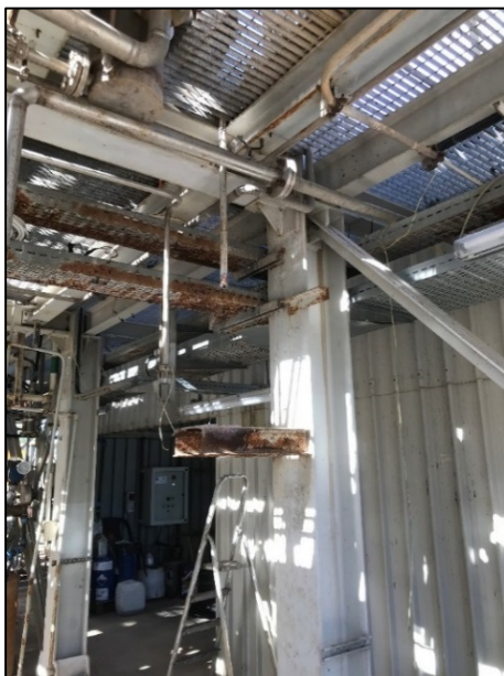
Figura 4.34 – Mensola di appoggio della pompa dosatrice CF003.
