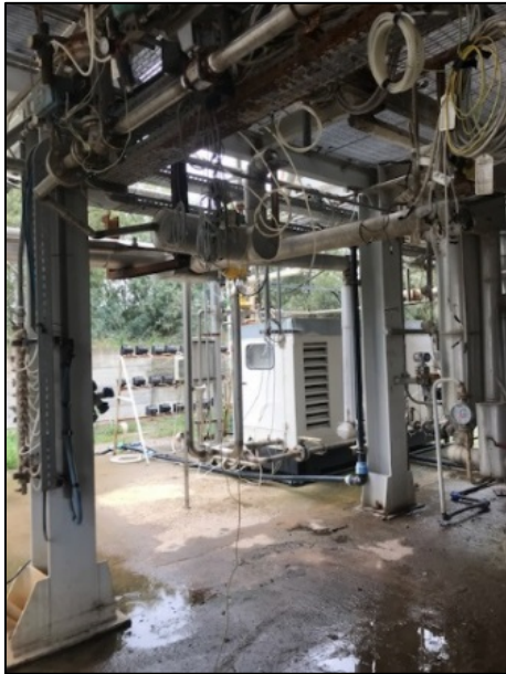
Figura 4.65 - Piano terra dopo la rimozione del riscaldatore.
