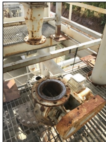
Figura 4.54- Rotocella disinstallata.
