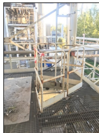
Figura 4.81 - Primo piano del castelletto a seguito della rimozione del reattore.
