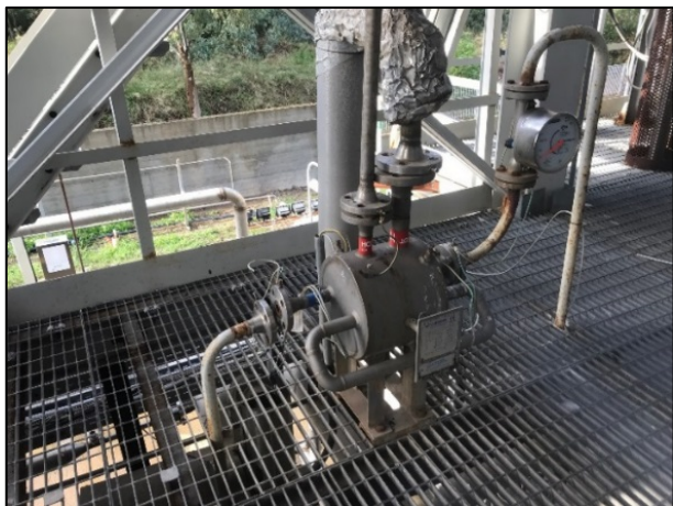
Figura 4.56 - Scambiatore di calore BA003.
