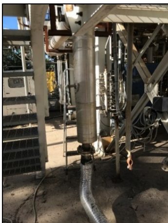
Figura 4.41 – Tubo di alimentazione agenti gassificanti ricollegata.
