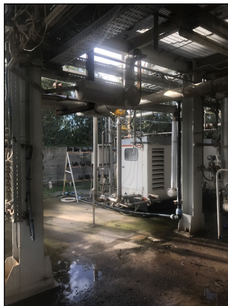
Figura 4.83 - Piano terra dopo la rimozione del reattore.
