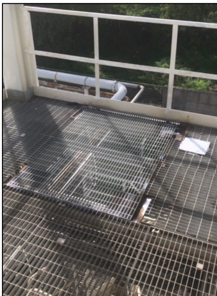
Figura 4.82. Grigliato del secondo piano dopo la rimozione del reattore.
