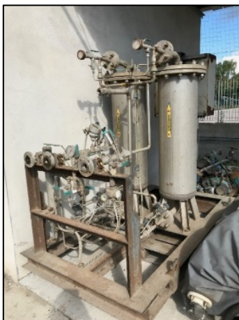
Figura 4.47 - PSA a seguito della disinstallazione.
