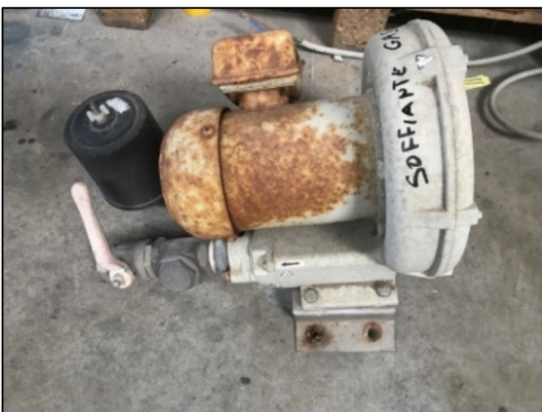
Figura 4.67 – Soffiante del gasometro dopo la rimozione.
