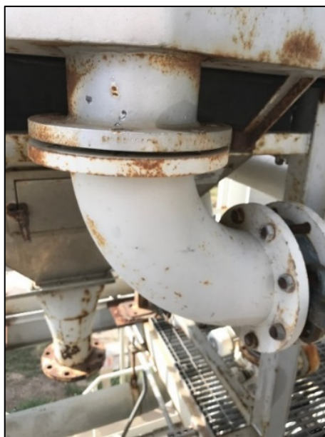
Figura 4.55 – Rimozione bulloni dai tubi di aspirazione polveri.
