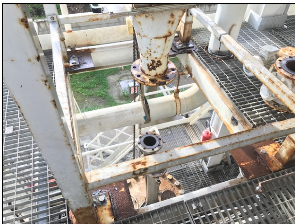
Figura 4.71 - Sostituzione bulloni bloccati da supporti tramoggia.
