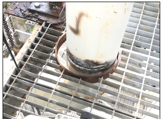
Figura 4.72 - Taglio tubazioni di aspirazione primo piano.
