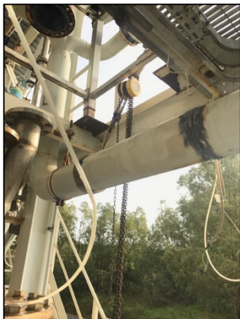
Figura 4.73 - Taglio tubazioni di aspirazione secondo piano.
