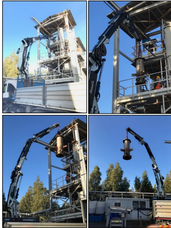
Figura 7- Fasi di rimozione del reattore di gassificazione
