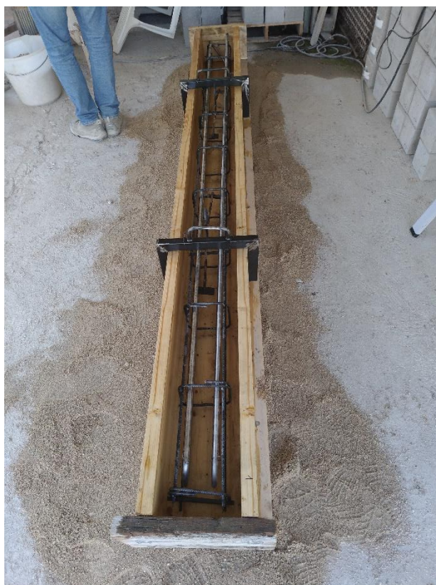
Figura 5-1 Foto del cassero in legno completo di aggrappaggi metallici. All'interno del cassero sono visibili il tubo di scambio termico e la gabbia di rinforzo.
