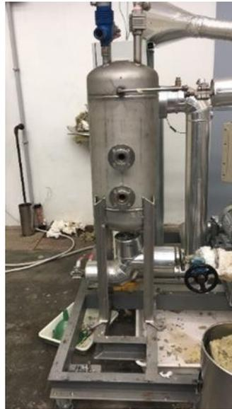
Figura 2-2- Serbatoio olio diatermico.
