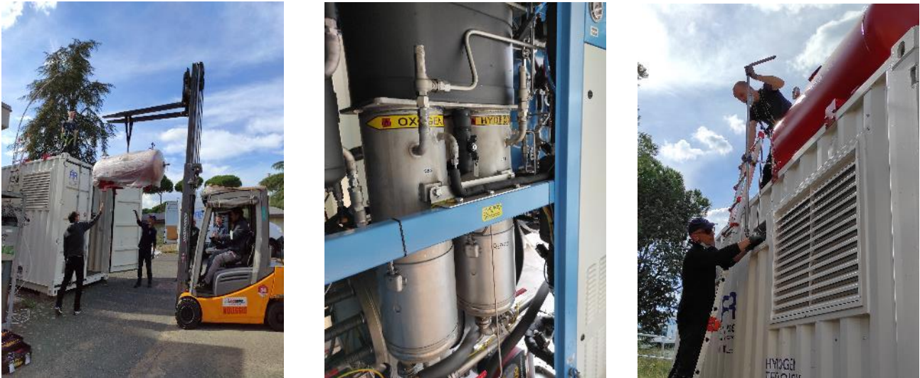
Fig. 6 – Installazione e collaudo del generatore di idrogeno c/o CRE Casaccia
