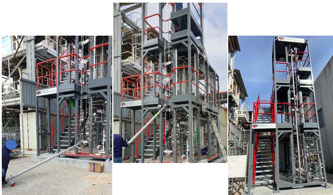
Figura 5.15. Posizionamento e installazione finale del reattore monotubolare.
