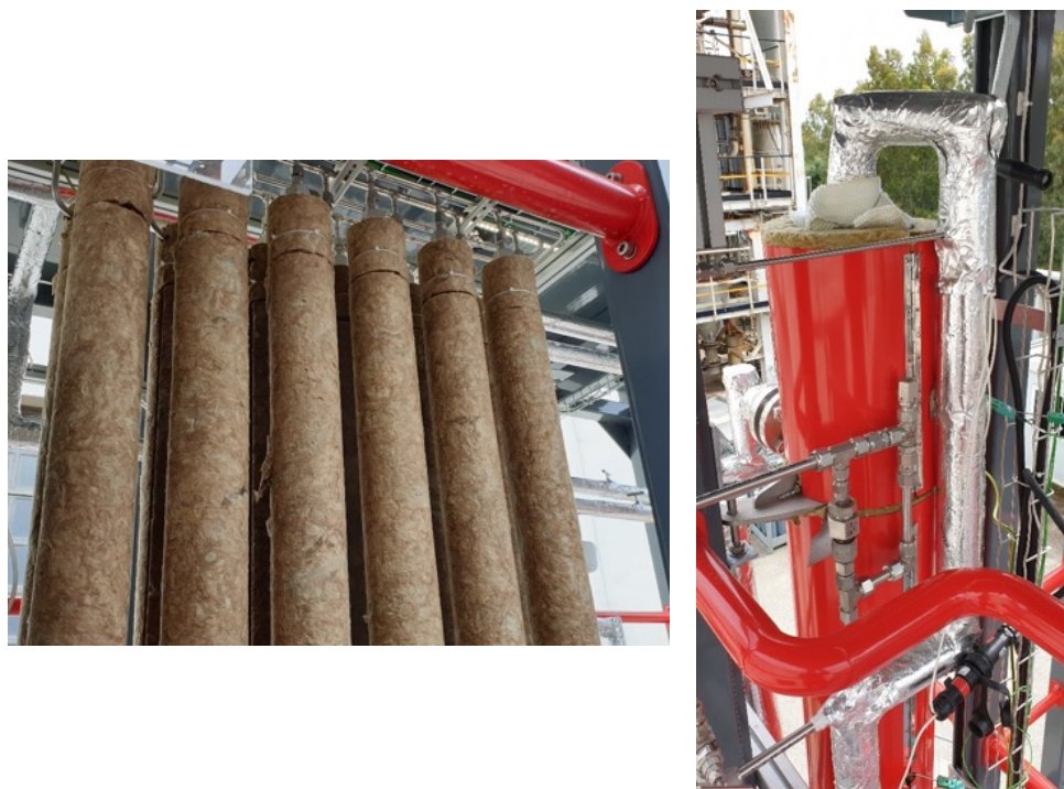
Figura 5.20. Primo strato di rivestimento termico per i 12 tubi costituenti il reattore multitubolare (sinistra) e coibentazione finale del reattore monotubolare (destra).
