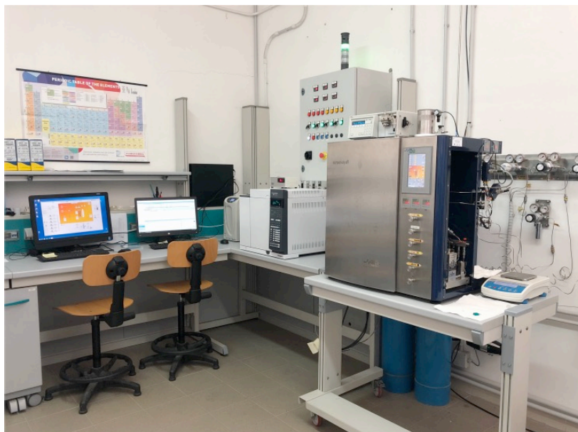
Figura 2.1. Impianto XtL installato presso il laboratorio Sotacarbo.
