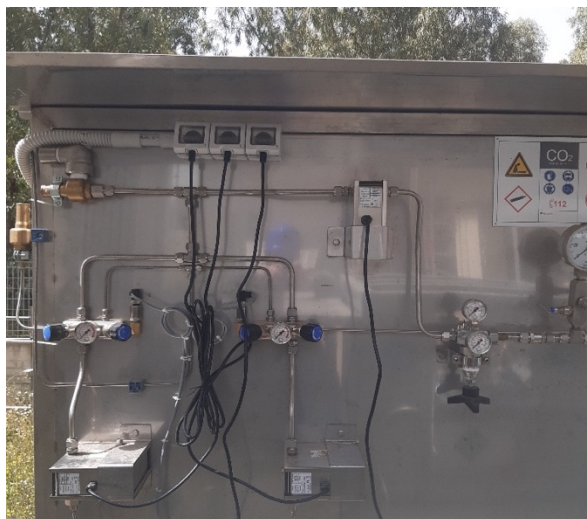
Figura 5.36. Centrale di riduzione della pressione dell'anidride carbonica.
