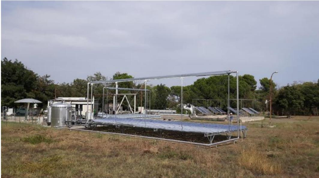
**Figura 6 – Foto del campo solare Linear-Fresnel in esercizio**
