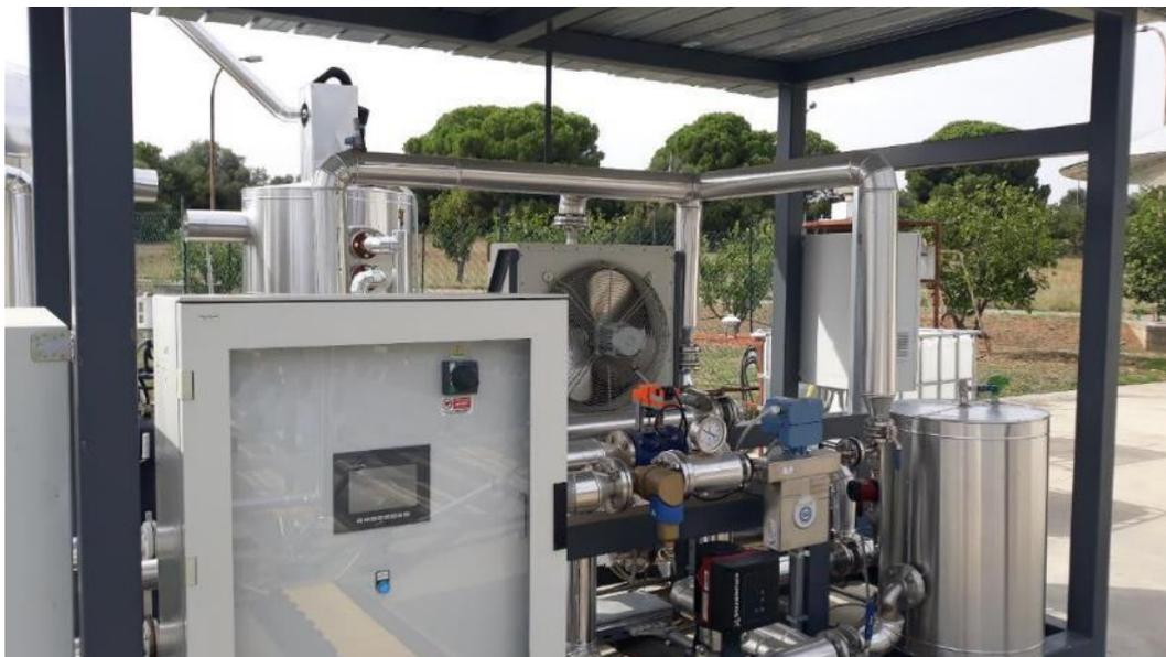
Figura 12 – Foto di dettaglio della skid utilizzata per la dissipazione del calore in regime controllato
