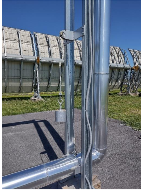
Figura 38. Sistema a carrucola per il sostegno della tubazione in ingresso al collettore solare.
