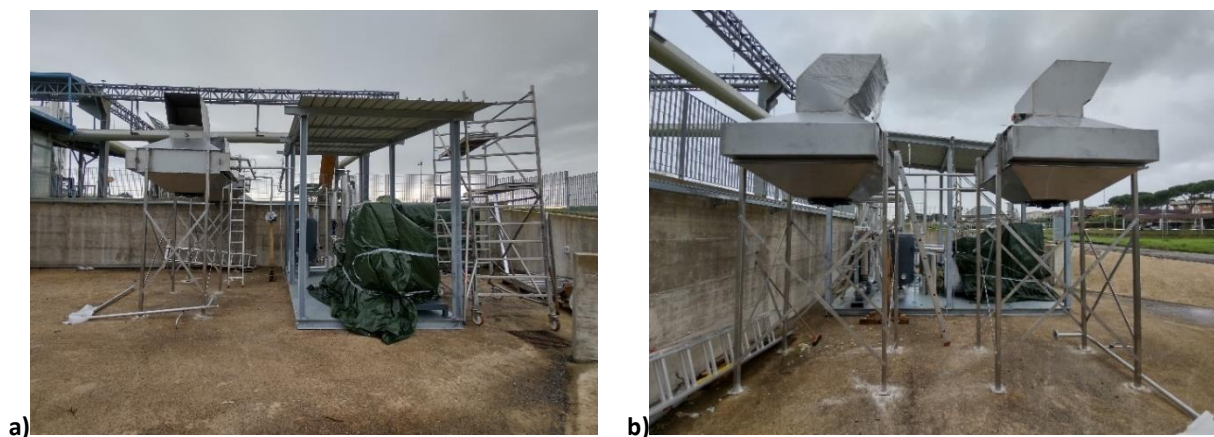
Figura 2. Piazzale designato per l'area componenti: a) vista frontale; b) vista di lato.
