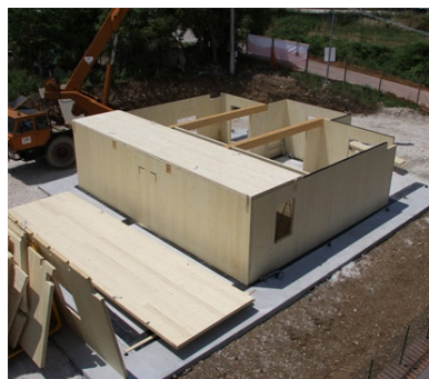
Figura 19. a) Struttura in telaio di legno lamellare; b) Struttura in pannelli di legno lamellare X-Lam.
