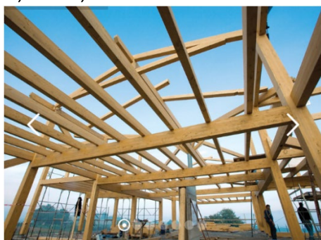
Figura 19. a) Struttura in telaio di legno lamellare; b) Struttura in pannelli di legno lamellare X-Lam.
