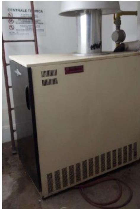
**Figura 74.** Generatore di calore.
