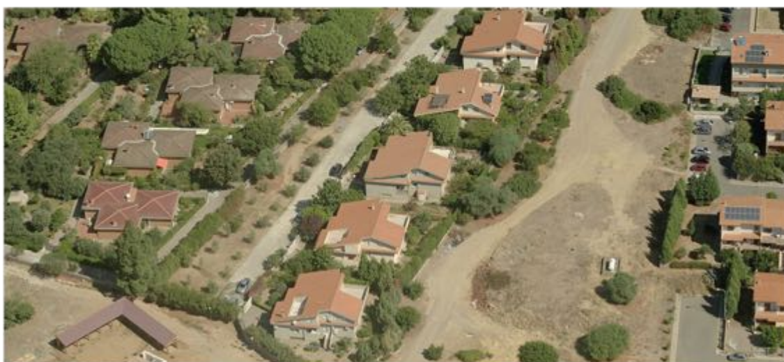
Vista 1-3, edifici isolati, zona B2.1
