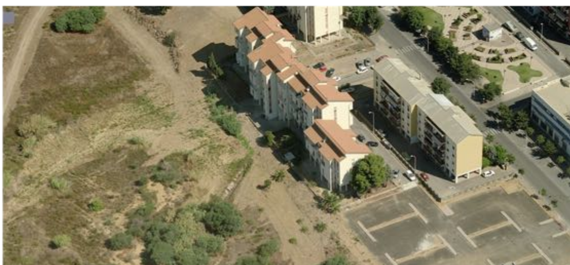
Vista 2-2, edifici a torre della zona B2.5
