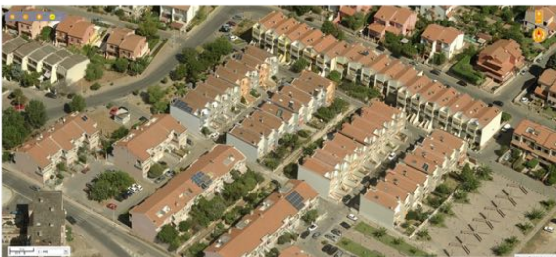
Vista 3-2, edifici in linea, zona C1.1 PdZ
