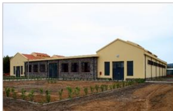
Centro Ricerche Sotacarbo (edificio storico della miniera)
