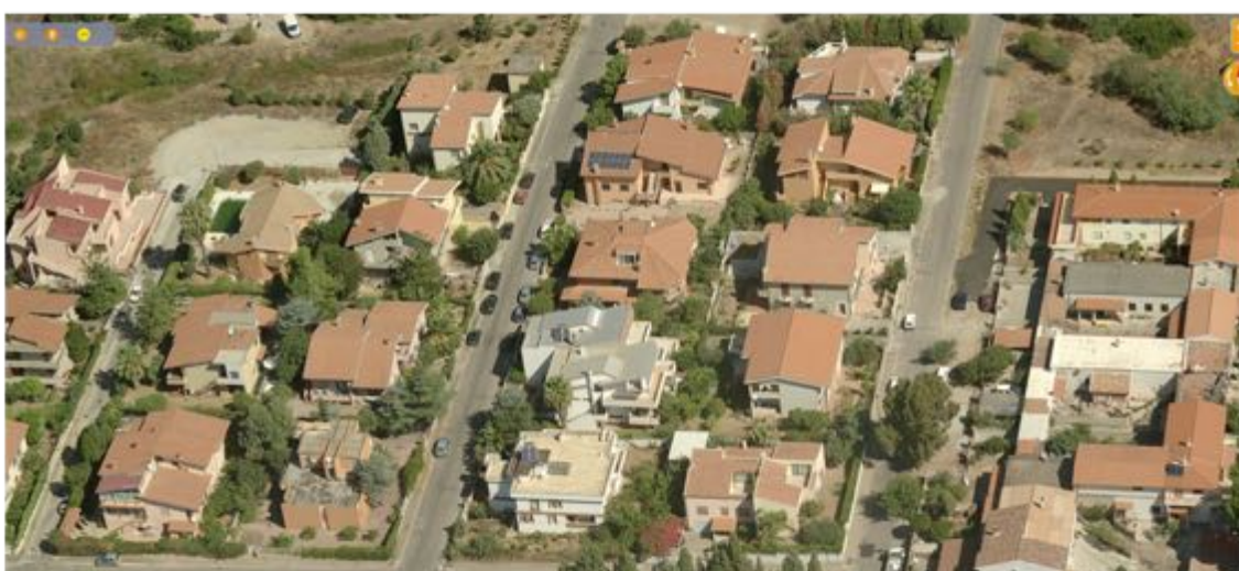
Vista 1-2, edifici isolati, zona B2.1
