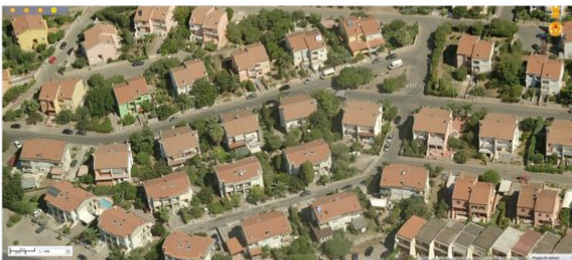
Vista 3-3, edifici isolati, zona C1.1 PdZ
