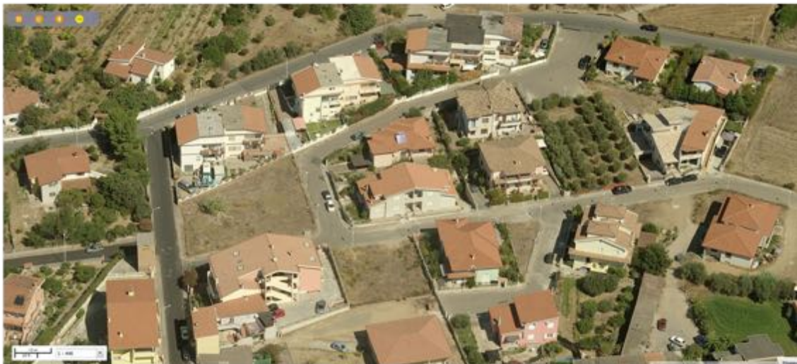
Vista 1-2, zona C1.1
