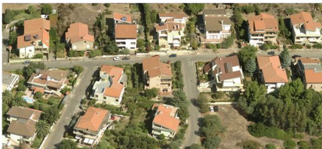
Vista 1-1, edifici isolati, zona B2.1
