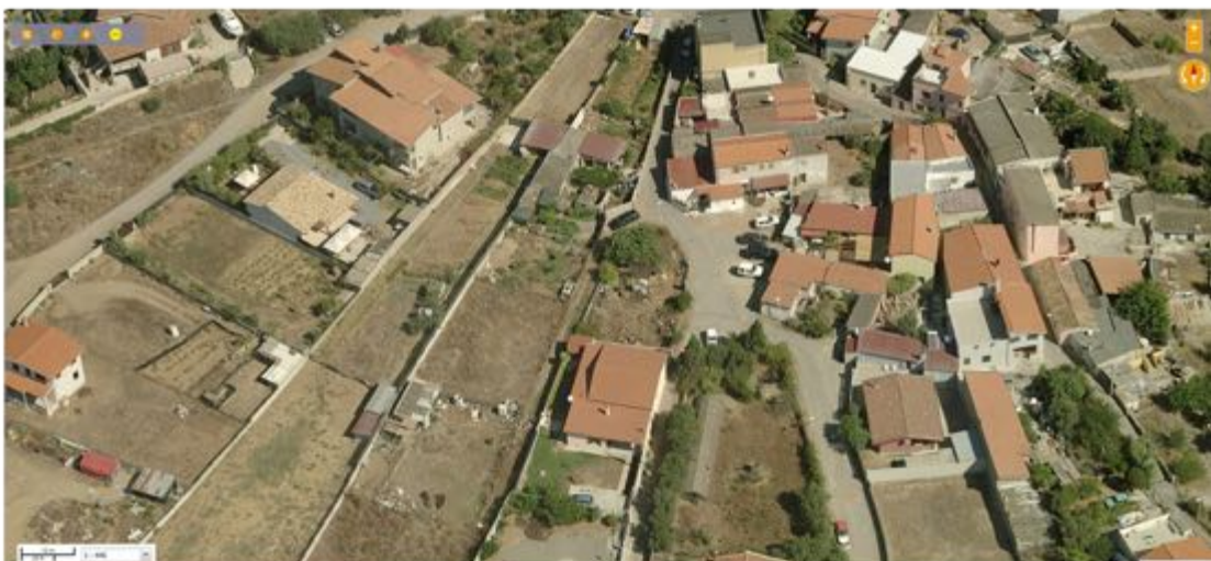
Vista 1-3, edifice zona B2.3
