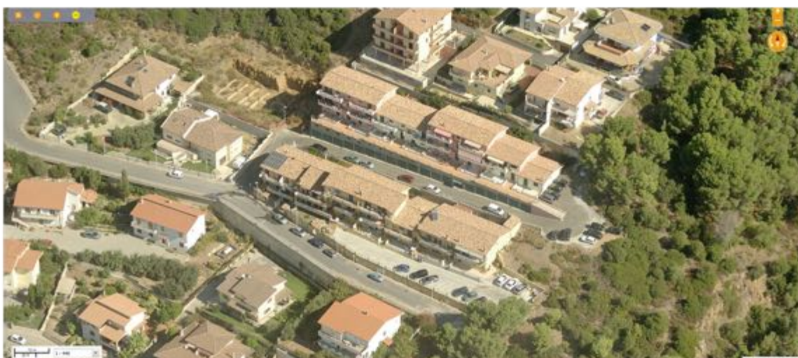
Vista 2-1, tipologie di edifici in linea zona C1.1
