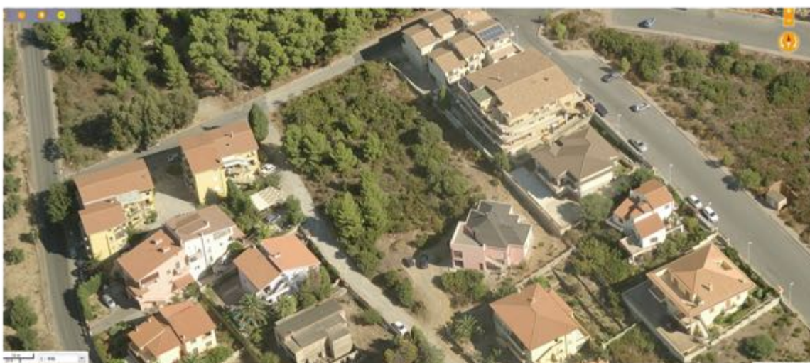
Vista 2-2, edifice isolati zona B2.2
