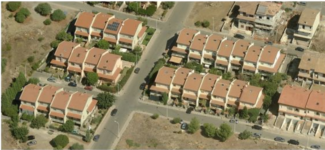
Vista 2-1, edifici in linea, zona C1.1 PdZ
