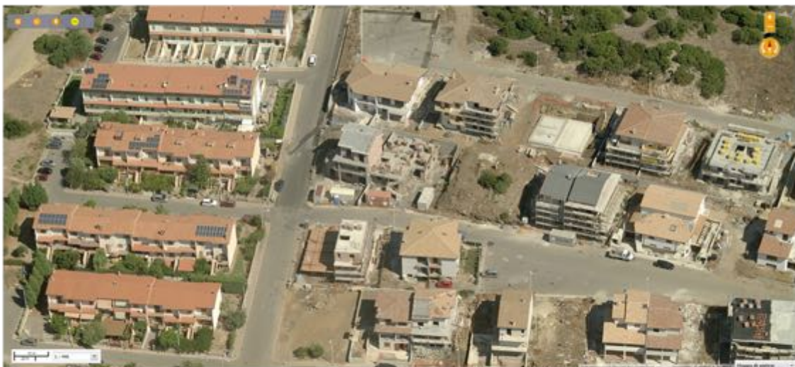
Vista 2-1, edifici in linea, zona C1.1 PdZ
