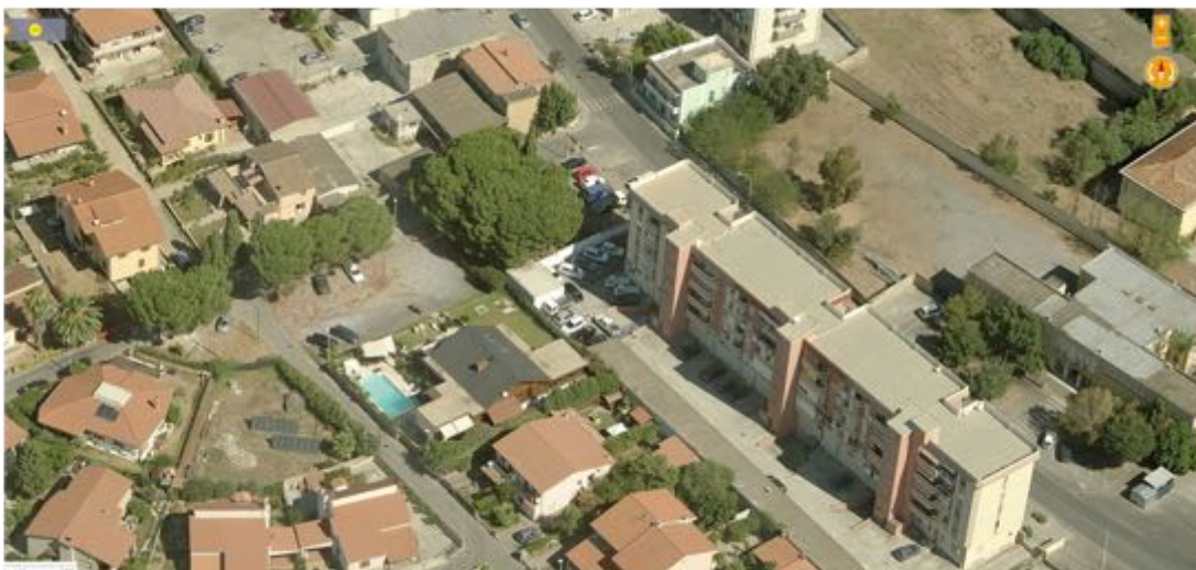
Vista 1-3, Edifici della Fondazione della zone A2.1
