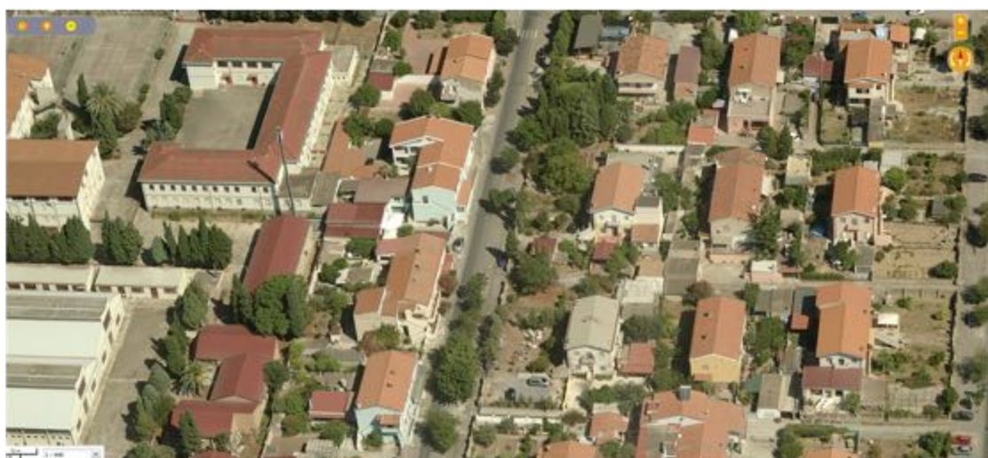
Vista 2-1, contatto tra zona B2.3 e zona A1.2
