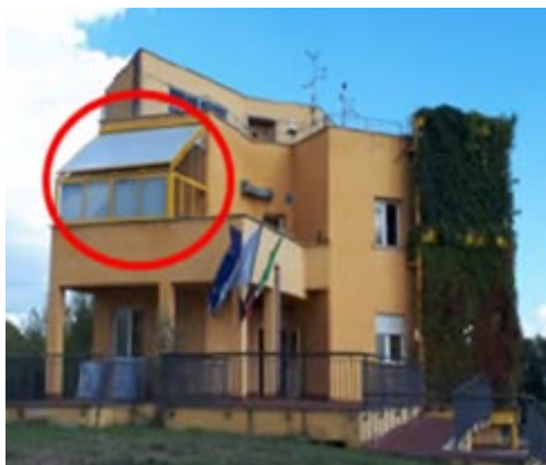
Figura 23. Prototipo di serra bioclimatica sull’edificio F92 “casa delle energie” dell’ENEA, Casaccia
