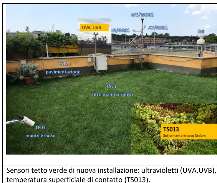
Figura 21. Disposizione nuovi sensori su tetto verde di tipo estensivo
