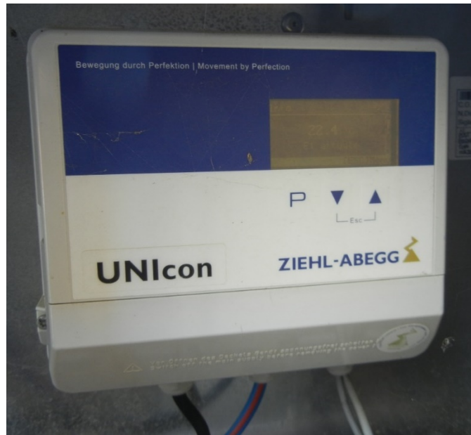
Figura 13: Display e interfaccia di dry cooler per la regolazione della velocità delle ventole.
