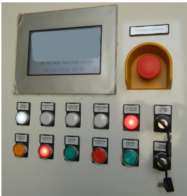
Figura 6: Compensatore statico e relativo quadro di connessione. A destra è visualizzato il display di controllo e i comandi manuali.
