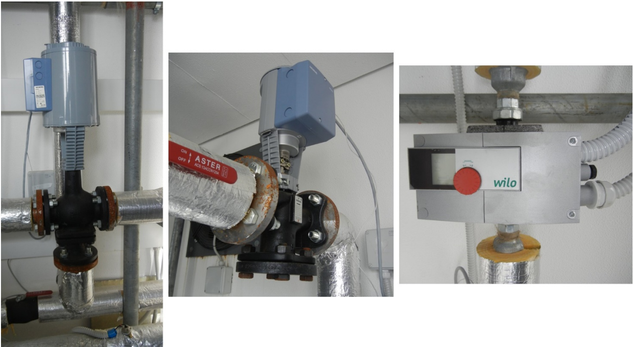
Figura 12: Sinistra: valvola a tre vie motorizzata – Centro: valvola a due vie motorizzata – Destra: circolatore.
