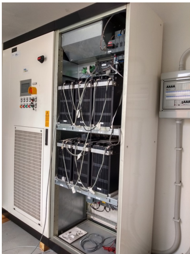
Figura 6: Compensatore statico e relativo quadro di connessione. A destra è visualizzato il display di controllo e i comandi manuali.
