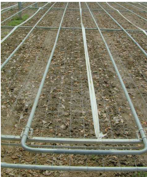
Figura 39. Sistema di riscaldamento a termosifone ad acqua calda a circolazione forzata ottenuto mediante la collocazione in serra di tubazioni in metallo di mandata e di ritorno complanari.
