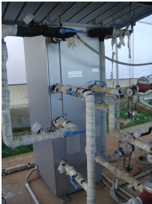
Figura 7. Chiller ad assorbimento (Yazaki WFC-SC 5) dell’impianto di solar cooling presso l’Università di Bari.
