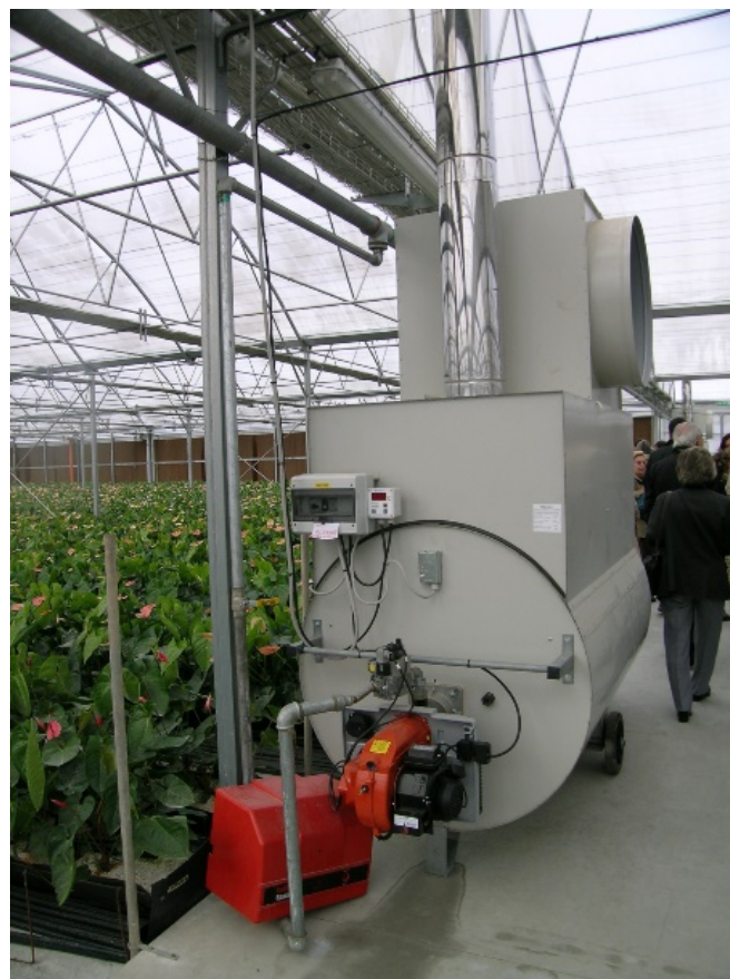
Figura 45. Generatore di aria calda mobile, impiegato come sistema di riscaldamento di soccorso in una serra floricola.
