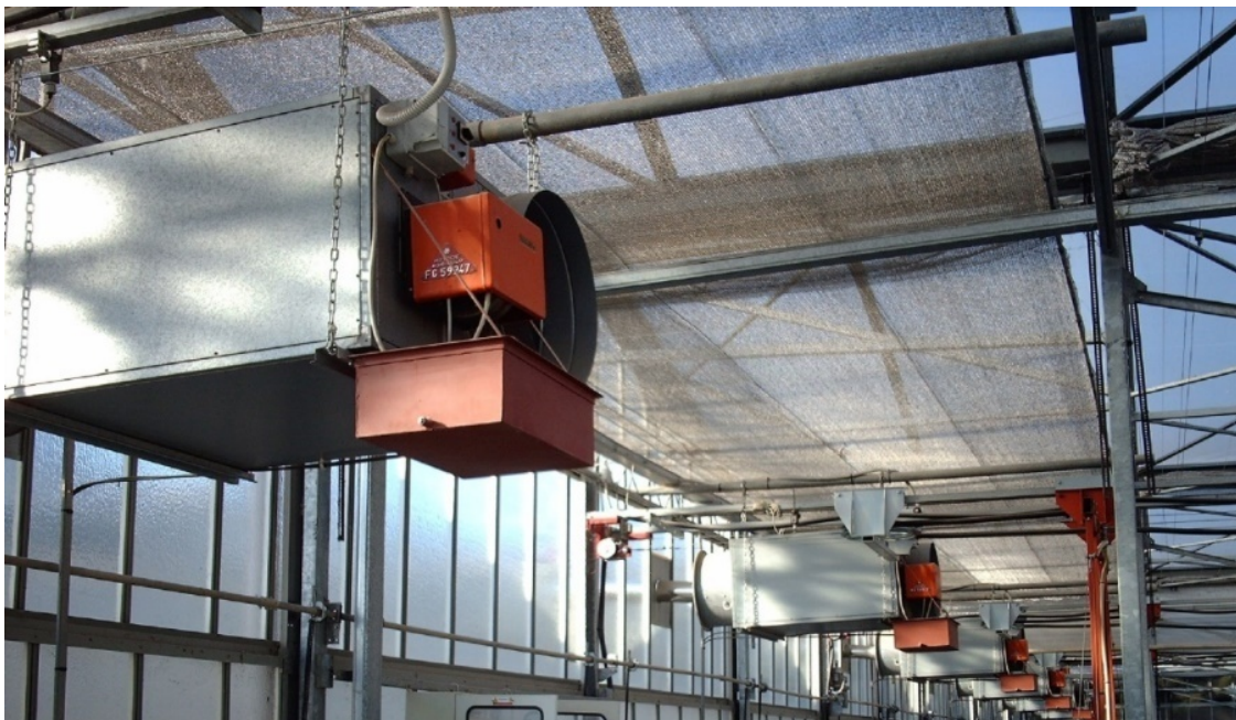
Figura 44. Generatori di aria calda di tipo fisso.
