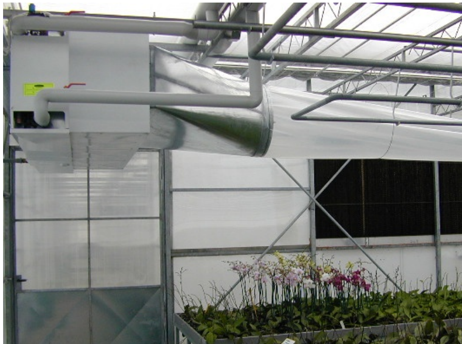
Figura 46. Canali in PE trasparente impiegati per una migliore diffusione di aria calda all'interno di una serra dedicata alla produzione floricola.
