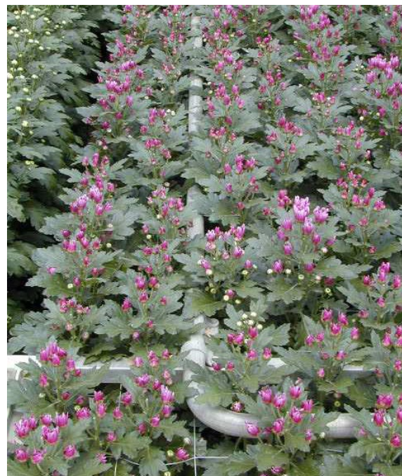
Figura 39. Sistema di riscaldamento a termosifone ad acqua calda a circolazione forzata ottenuto mediante la collocazione in serra di tubazioni in metallo di mandata e di ritorno complanari.
