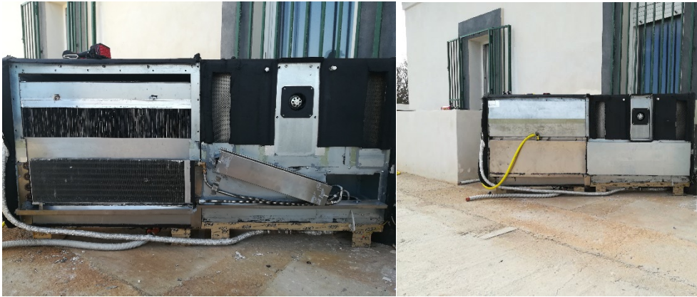
Figura 2.50. Lavori di riposizionamento dello scambiatore di calore utilizzato per il raffreddamento dei letti adsorbenti e del ventilatore secondario
