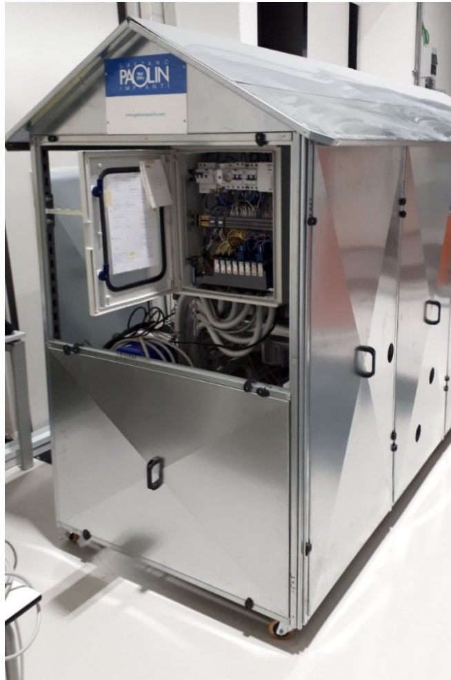
Figura 20. Sottostazione completamente assemblata
