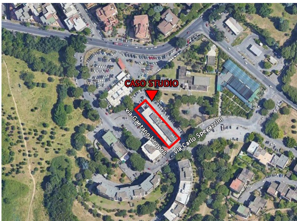
Figura 33. Individuazione dell'edificio (da Google Earth).
