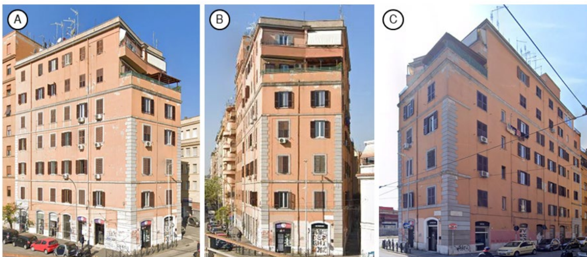
Figura 2. Prospetti sud-est (A – Viale dello Scalo San Lorenzo), nord-est (B – Via dei Reti) e nord-ovest (C – Via degli Enotri).
