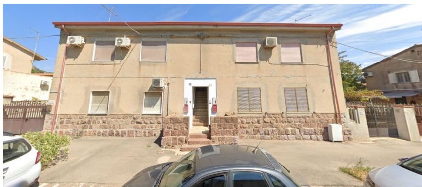
Figura 4: Edificio GRA-M allo stato attuale
