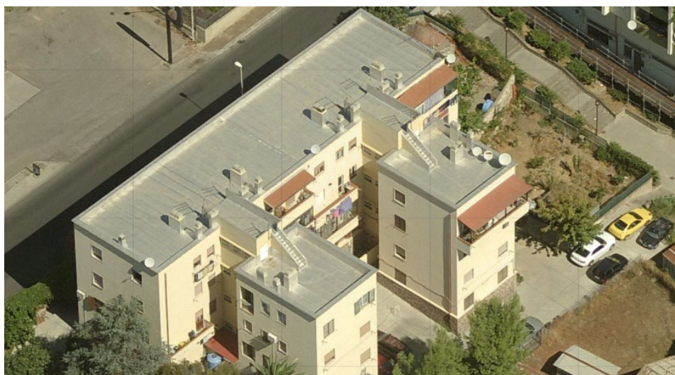
Figura 2: Edificio Pistoni O/5 allo stato attuale
