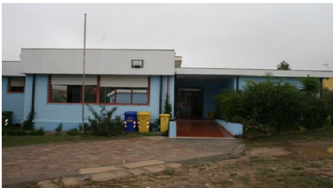
Figura 16: Scuola primaria Is Gannaus allo stato attuale
