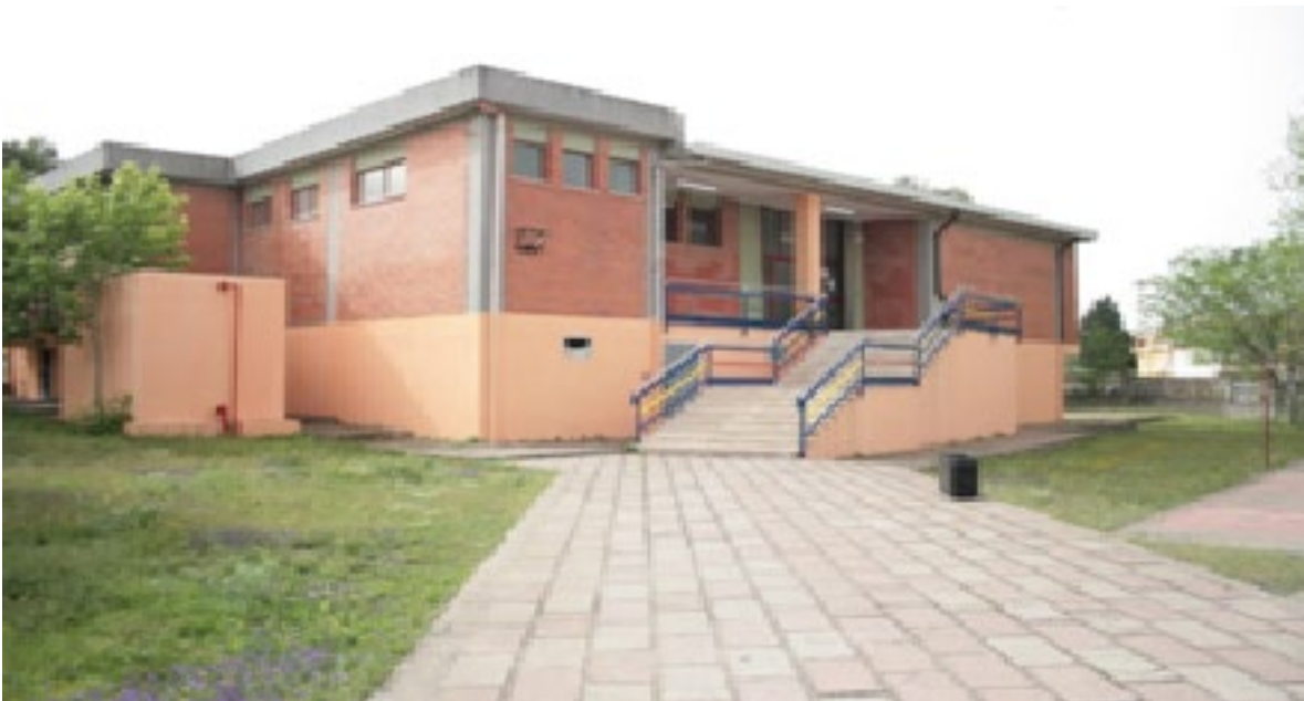
Figura 15: Scuola primaria Is Meis allo stato attuale
