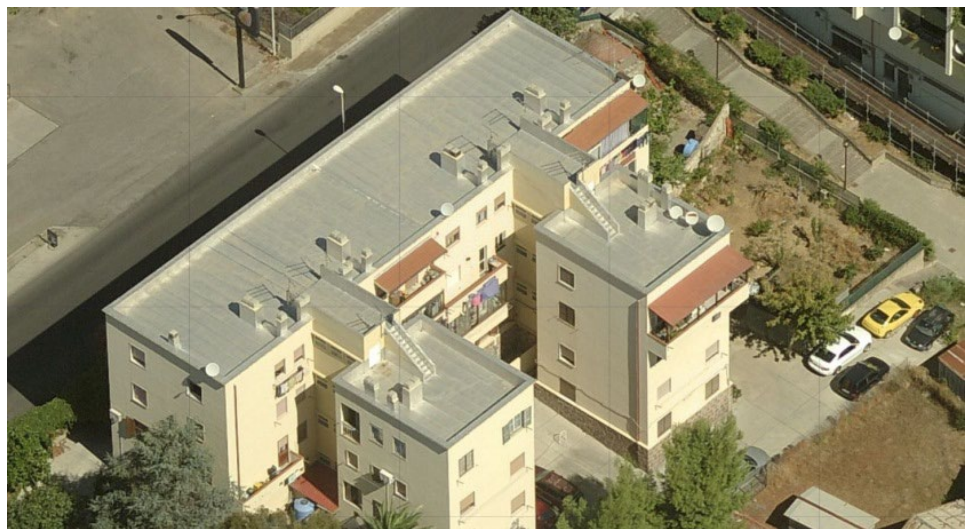
Figura 3: Edificio Pistoni O/5 allo stato attuale
