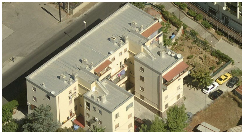
Figura 1: Edificio Pistoni O/5 allo stato attuale
