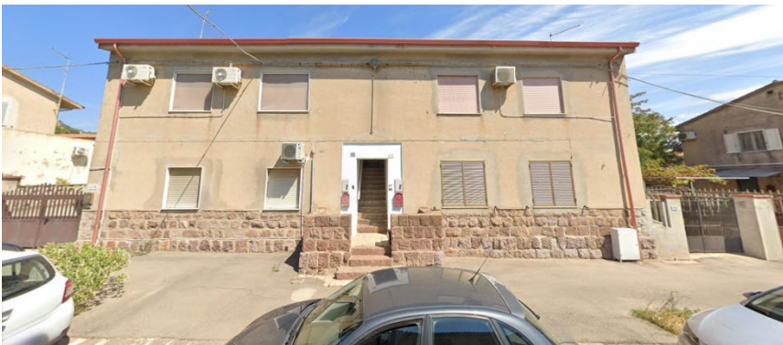
Figura 5: Edificio GRA-M allo stato attuale
