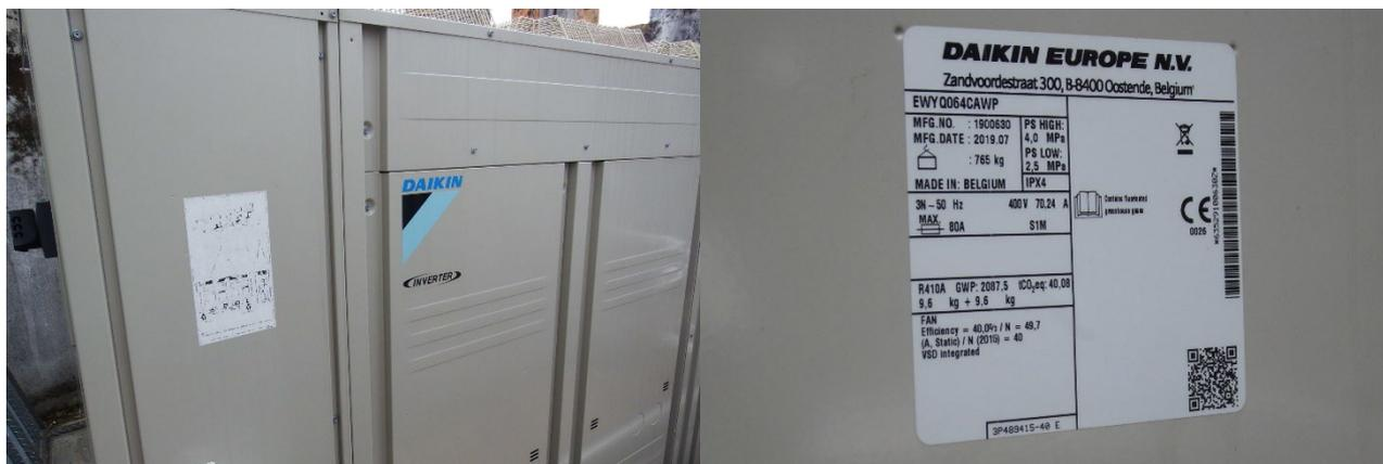
Figura 5-6 Una delle due pompe di calore Daikin EWYQ064CAWP posizionate sulla torretta aperta
