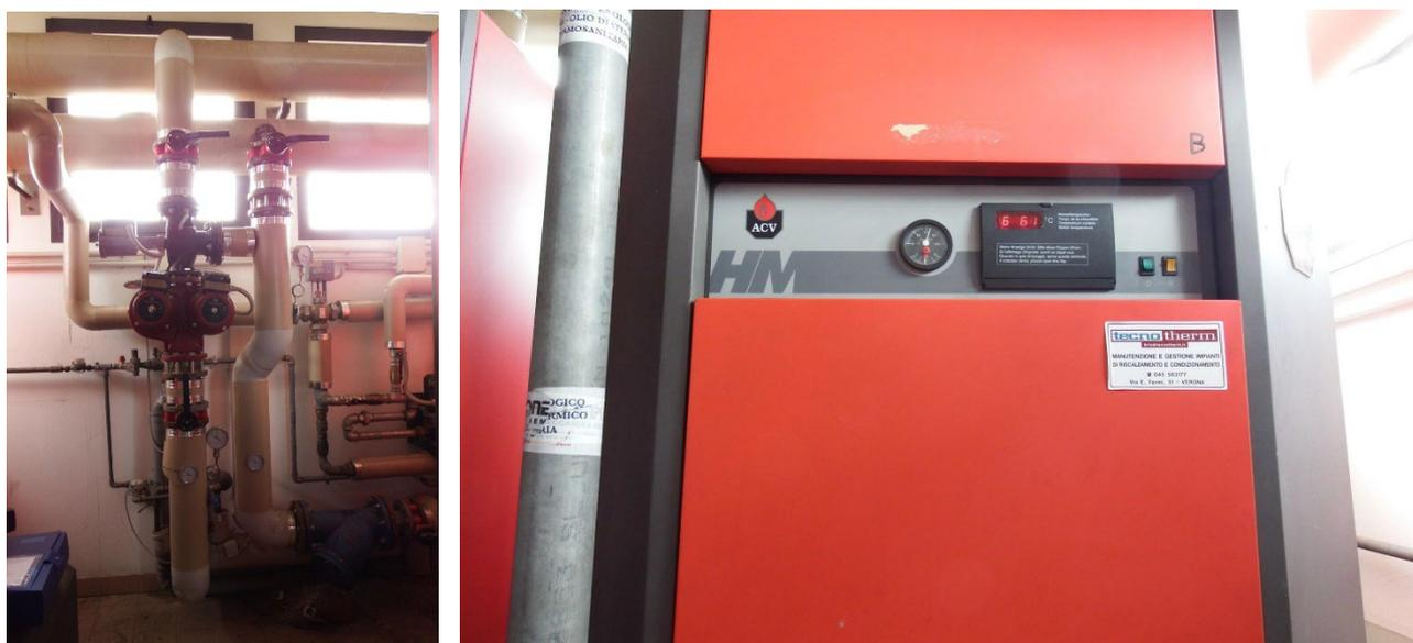
Figura 5-5 A sinistra foto della pompa gemellare Grundfos, a destra foto della caldaia ACV
