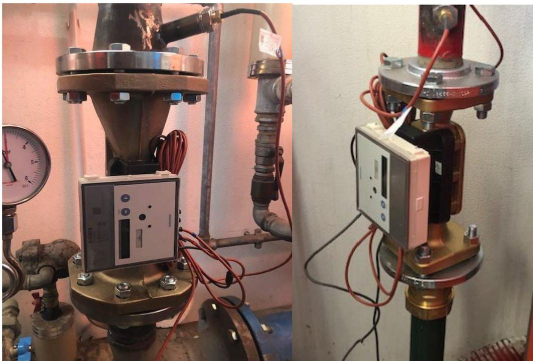
**Figura 5-11** Sensori Siemens installati all'interno della centrale termica di Corte Veronica: a sinistra a monte del disgiuntore (T01) e a destra a monte dell'accumulo di acqua calda sanitaria (T02)
