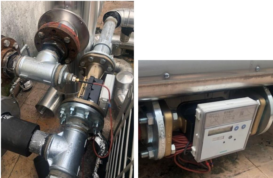
**Figura 5-10 Sensori Siemens installati secondo normativa sulle pompe di calore nella torretta aperta di Corte Veronica.**
