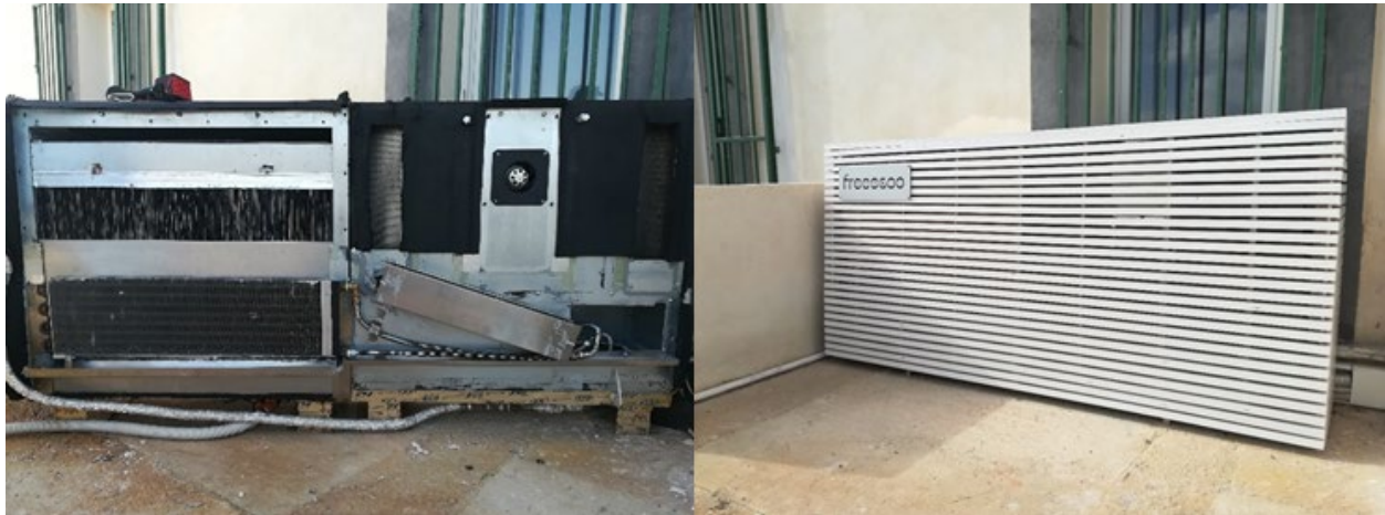
Figura 3-11: Sistema Freesco compatto installato a parete: a destra foto componenti interni della macchina, a sinistra posizionamento del sistema completo
