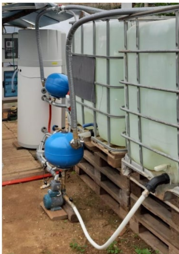
Figura 4-14: Rappresentazione dei serbatoi di accumulo inerziale: due serbatoi a vasi chiusi collegati in serie installati presso il laboratorio sperimentale di Marsala (TP).
