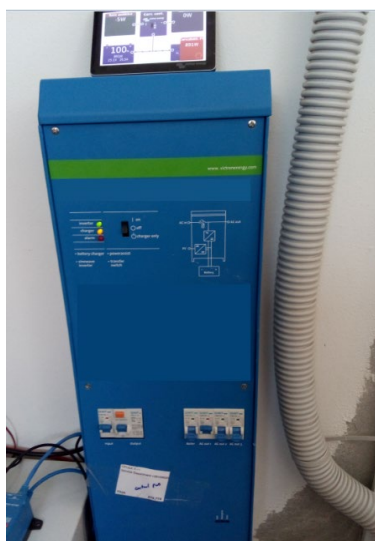
Figura 2-14: Nuovo convertitore ibrido con regolatore di carica solare e relativo display
