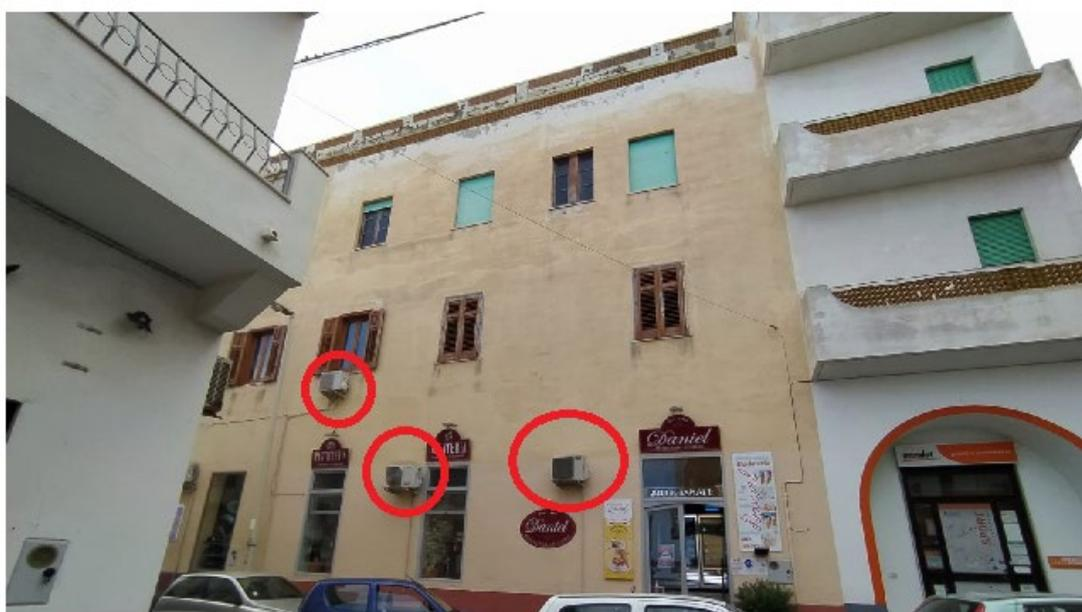
Figura 83. Alcuni esempi di unità esterne per impianti di condizionamento.
