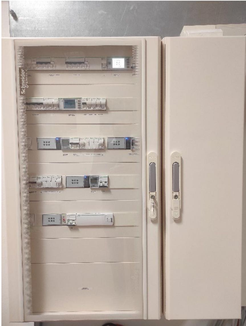
**Figura 65. Quadro elettrico di alimentazione, gestione e monitoraggio smart prosumer.**
