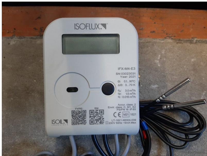
**Figura 42** – Foto del contacalorie per la contabilizzazione dello scambio termico acqua-fumi.
