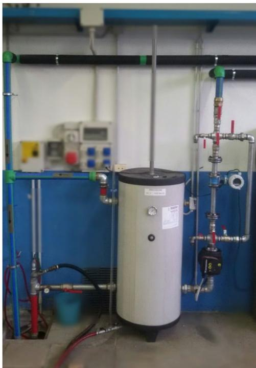
**Figura 24** – Foto del serbatoio dell'acqua di raffreddamento installato in Laboratorio e di parte del circuito relativo.
