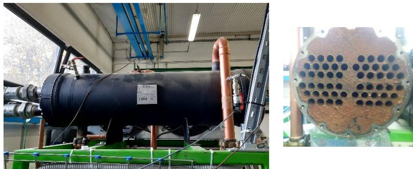
**Figura 46** – Fotografie del condensatore a fascio tubiero.
