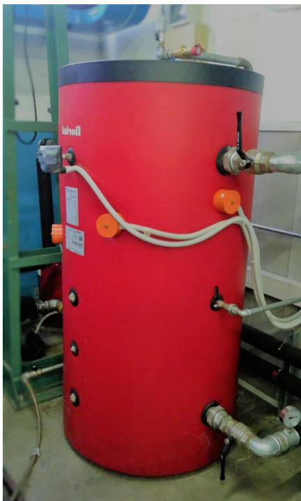
**Figura 48** – Fotografia del puffer (riscaldatore elettrico).
