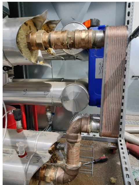
Figura 5.144. Scambiatore sovradimensionato (sinistra) e scambiatore sostitutivo (destra)
