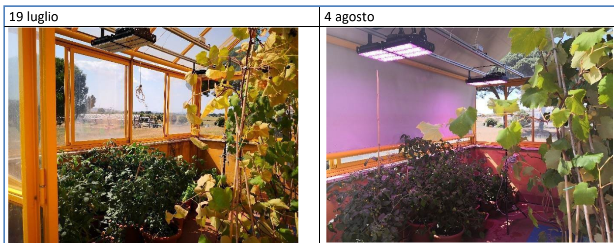
Figura 69. A sinistra, la serra bioclimatica è senza ombreggianti (19 luglio 2021); a destra, la serra è ombreggiata con le tende oscuranti e le luci a LED sono accese (4 agosto 2021). In entrambe le giornate le finestre sono parzialmente aperte
