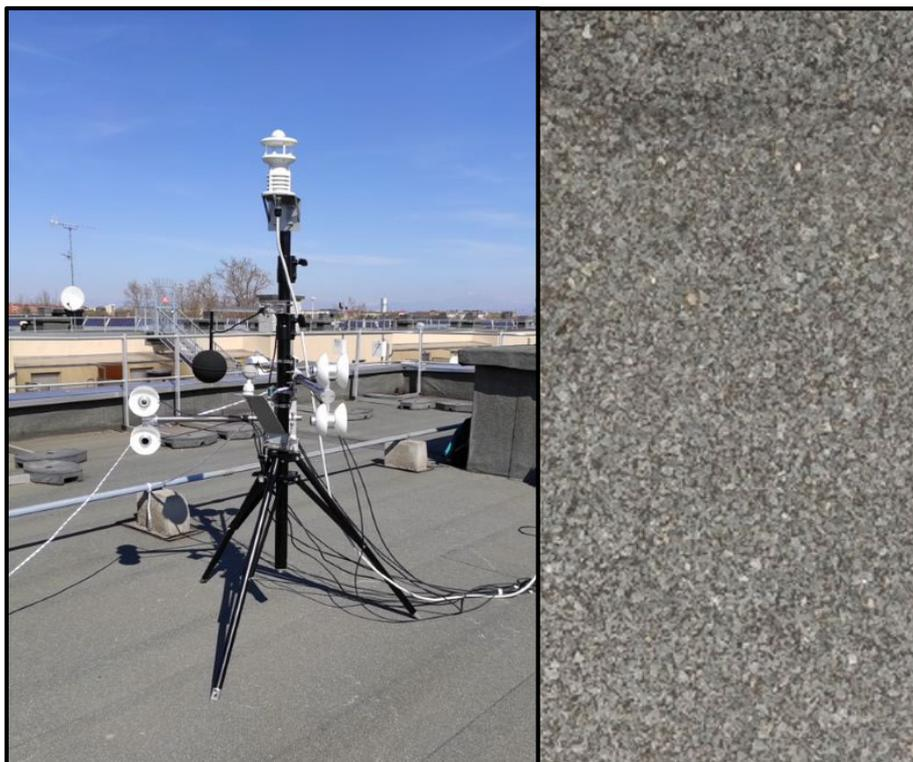
Figura A.23: Dal 23/03/2021 al 26/03/2021, Via Feltrinelli 16, MI: Superficie orizzontale: membrana bituminosa ardesiata.
