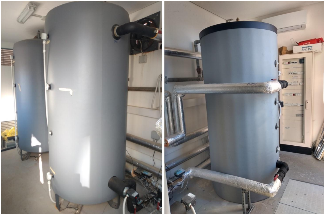
Figura 6: Sinistra: accumuli inerziali caldo/freddo. Destra: accumulo ACS.
