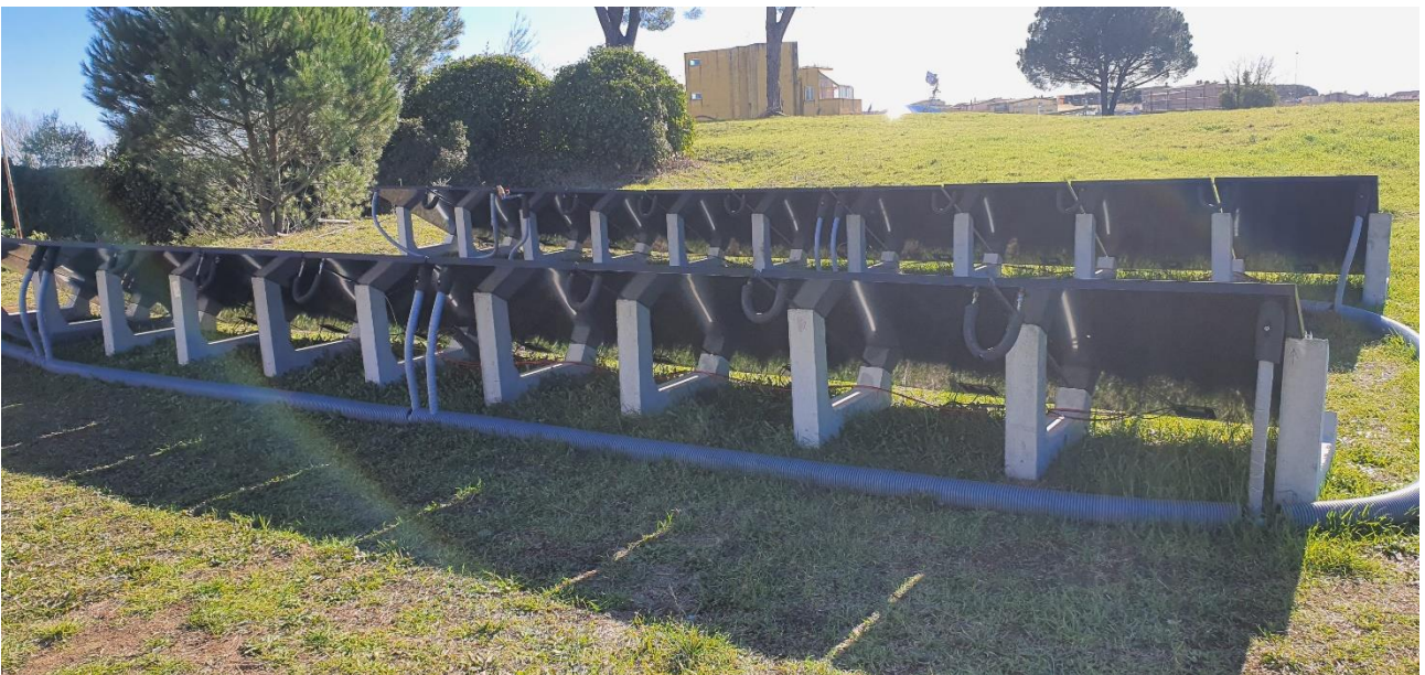
Figura 69: Vista posteriore dell'impianto PVT ultimato.
