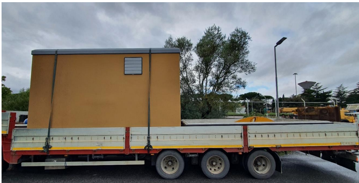
Figura 57: Trasporto cabina e vasca di fondazione prima dell’installazione.
