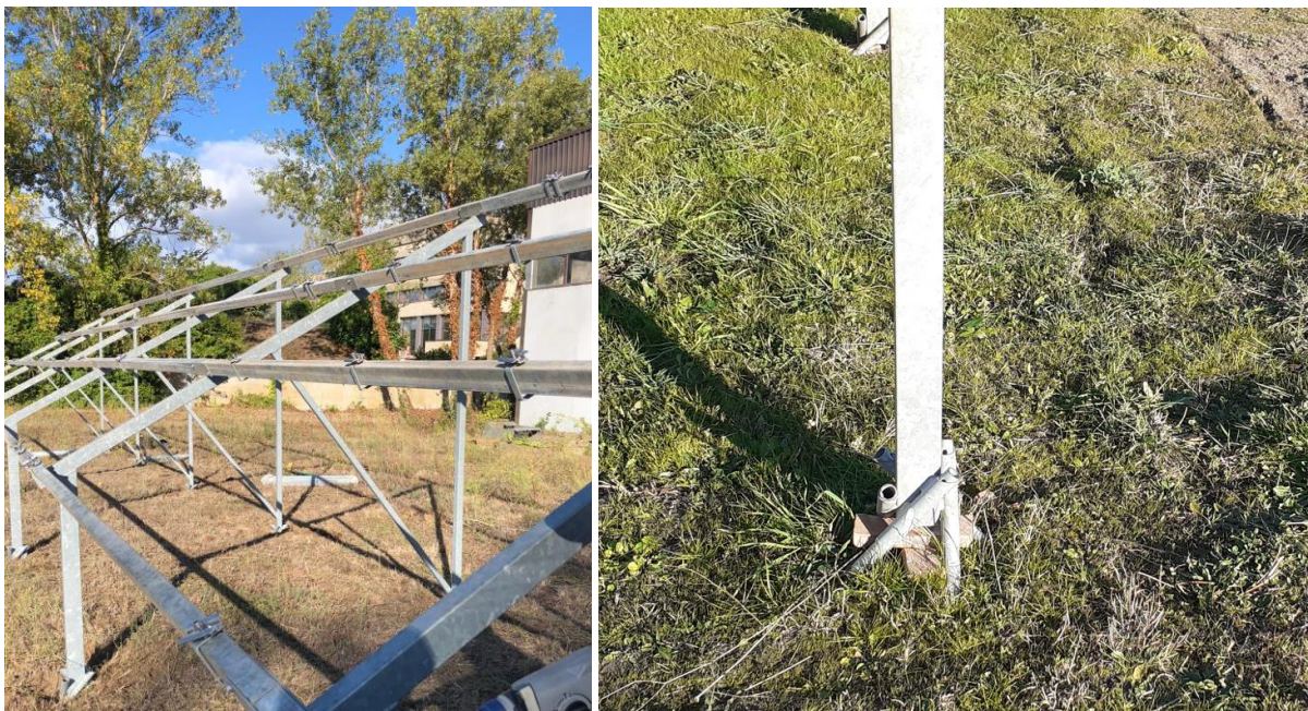
Figura 25: Particolare della struttura di sostegno dei moduli fotovoltaici in fase di installazione.
