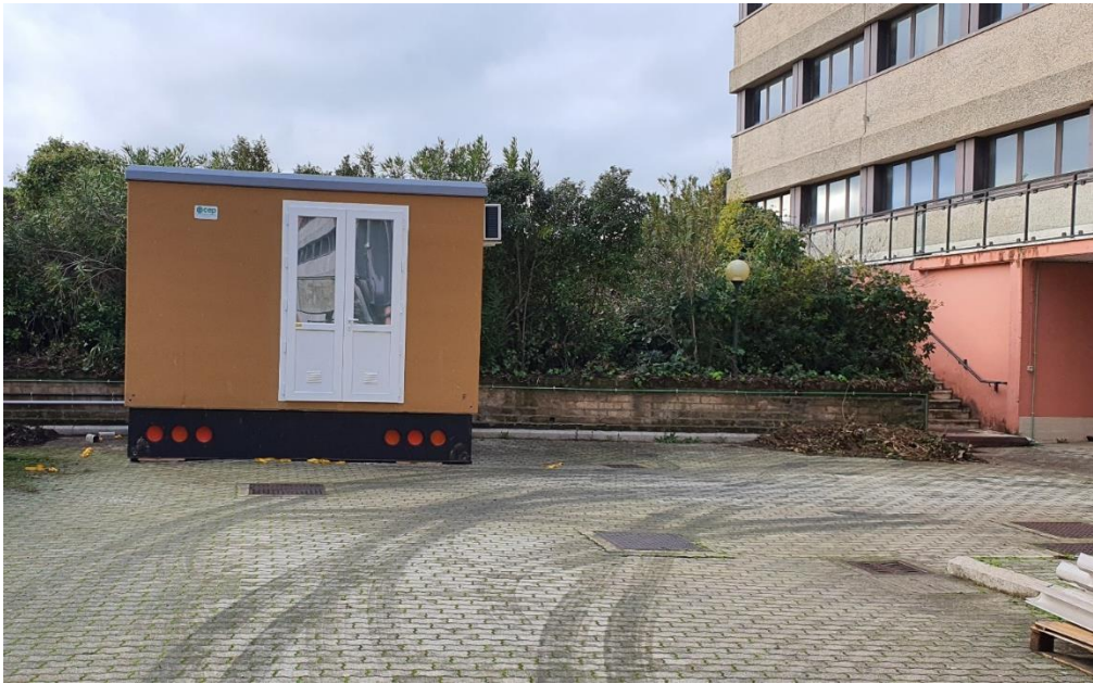
Figura 60: Posizionamento della vasca di fondazione e della cabina nel sito di installazione.
