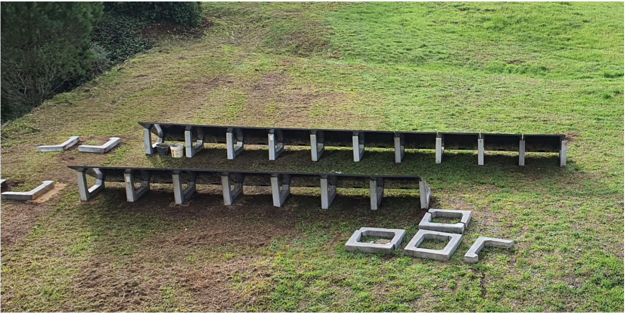
Figura 68: Impianto PVT con zavorre e pannelli in fase di installazione.
