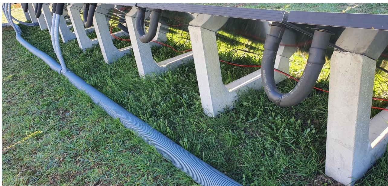
Figura 70: Dettaglio della connessione in serie tra i moduli PVT.
