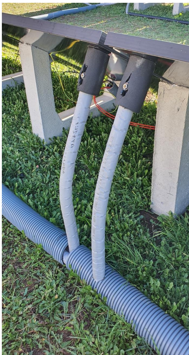
Figura 70: Dettaglio della connessione in serie tra i moduli PVT.
