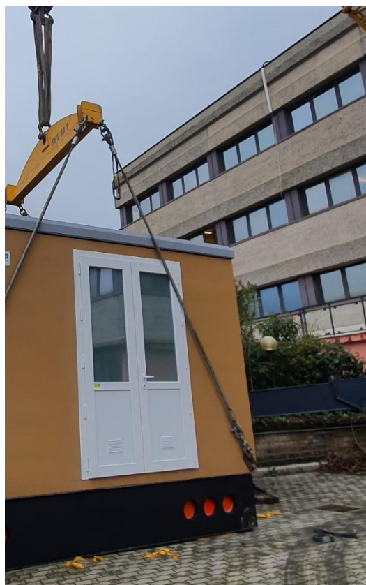
Figura 59: Operazioni di posizionamento della cabina sulla vasca di fondazione.
