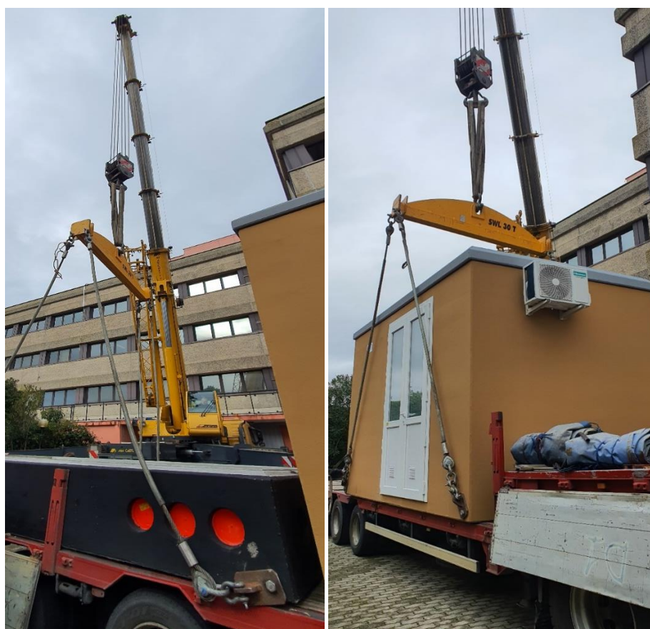
Figura 58: Movimentazione con gru della cabina e della vasca di fondazione.
