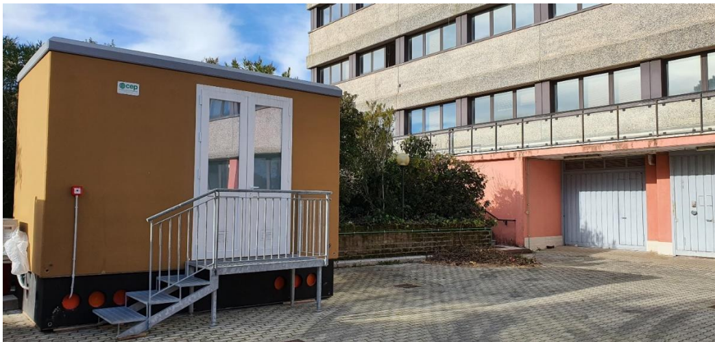
Figura 61: Installazione della cabina completa con scala di accesso.
