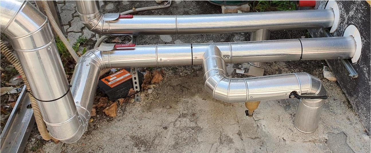
**Figura 6:** dettaglio Connessione alla tubazione del circuito idraulico drycooler – accumulo caldo/freddo, installazione valvole a tre vie manuali e filtro defangatore
