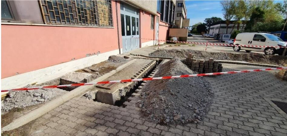
**Figura 2: Lavori in corso per lo realizzazione dello scavo necessario al posizionamento delle tubazioni di collegamento termico dell'impianto S.A.P.I.EN.T.E. al montante termico 1 dell'edificio F-83.**
