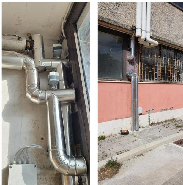
**Figura 3: Vista interna ed esterne del locale tecnico e del punto di connessione alla condotta di manda e ritorno della colonna montante con installazione delle due valvole a 3 vie motorizzate**
