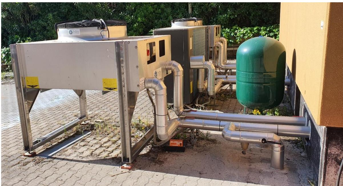
**Figura 5: Connessione alla tubazione del circuito idraulico drycooler – accumulo caldo/freddo**
