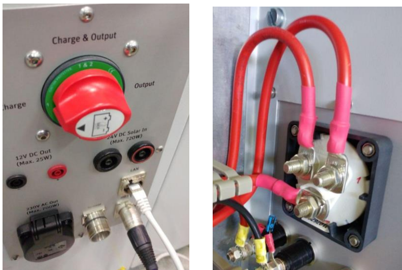
Figura 13 - Fronte e retro del deviatore a quattro vie
