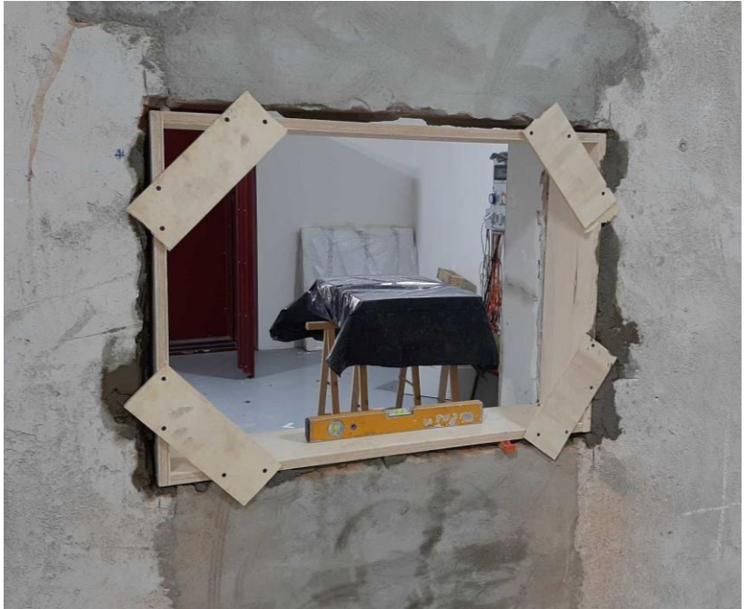
Figura 30: montaggio del controtelaio.
