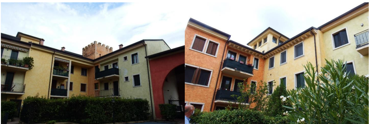
Figura 3-2 Sulla sinistra foto di una delle torri sulle quali sono situate le unità adibite al raffrescamento, sulla destra foto di una delle torri chiuse e contenenti la centrale termica.
