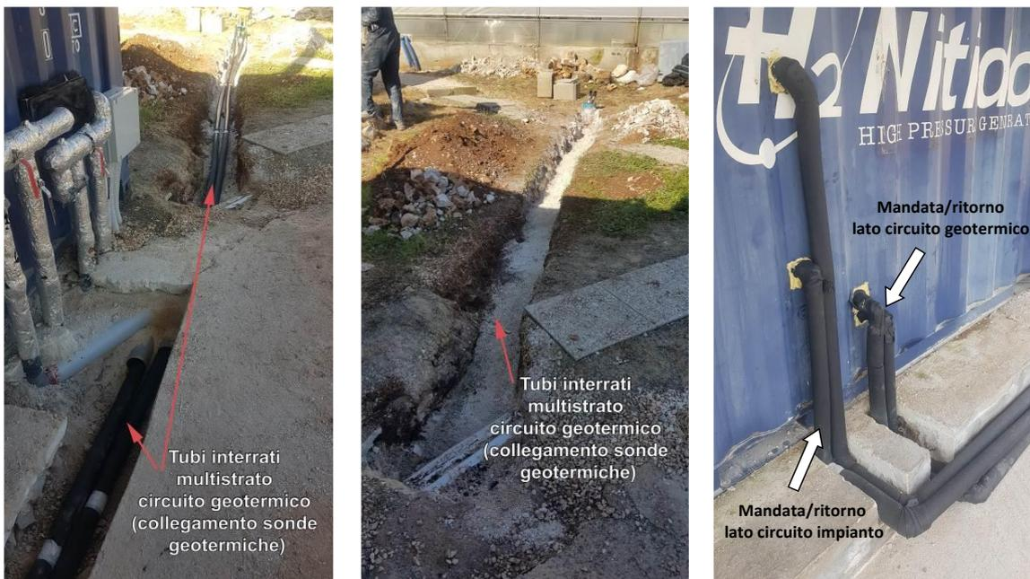
**Figura 95. Tubi di mandata alla pompa di calore e ritorno alle sonde (lato circuito geotermico) e tubi di mandata all’utenza e ritorno alla pompa di calore (lato circuito impianto)**
