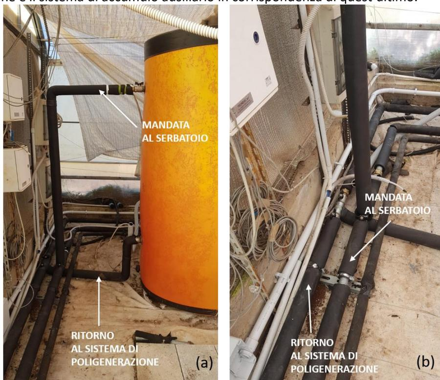
**Figura 106. Collegamento tra il sistema di poligenerazione ed il serbatoio di accumulo: vista in corrispondenza del serbatoio (interno alla serra) (a) e dettaglio delle tubazioni di mandata e ritorno (b)**
