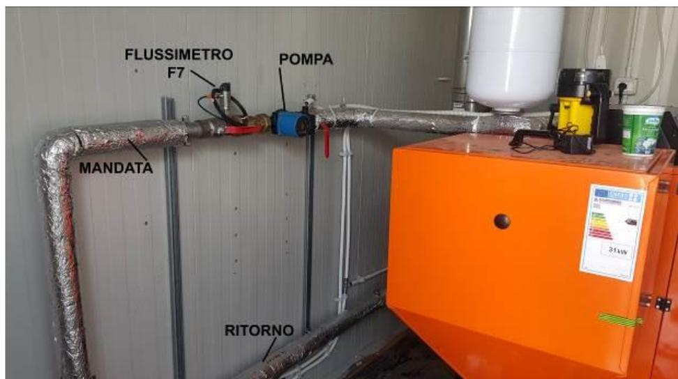
**Figura 81. Condotte di mandata dalla caldaia al serbatoio e di ritorno dal serbatoio alla caldaia: vista all'interno del container**
