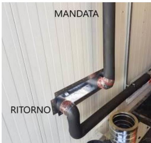
**Figura 82. Particolare delle condotte di mandata dalla caldaia al serbatoio e di ritorno dal serbatoio alla caldaia**
