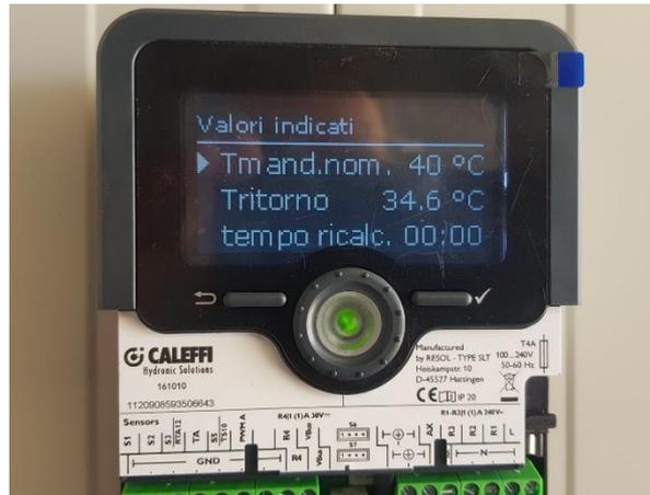
**Figura 89. Centralina per il controllo della valvola miscelatrice**
