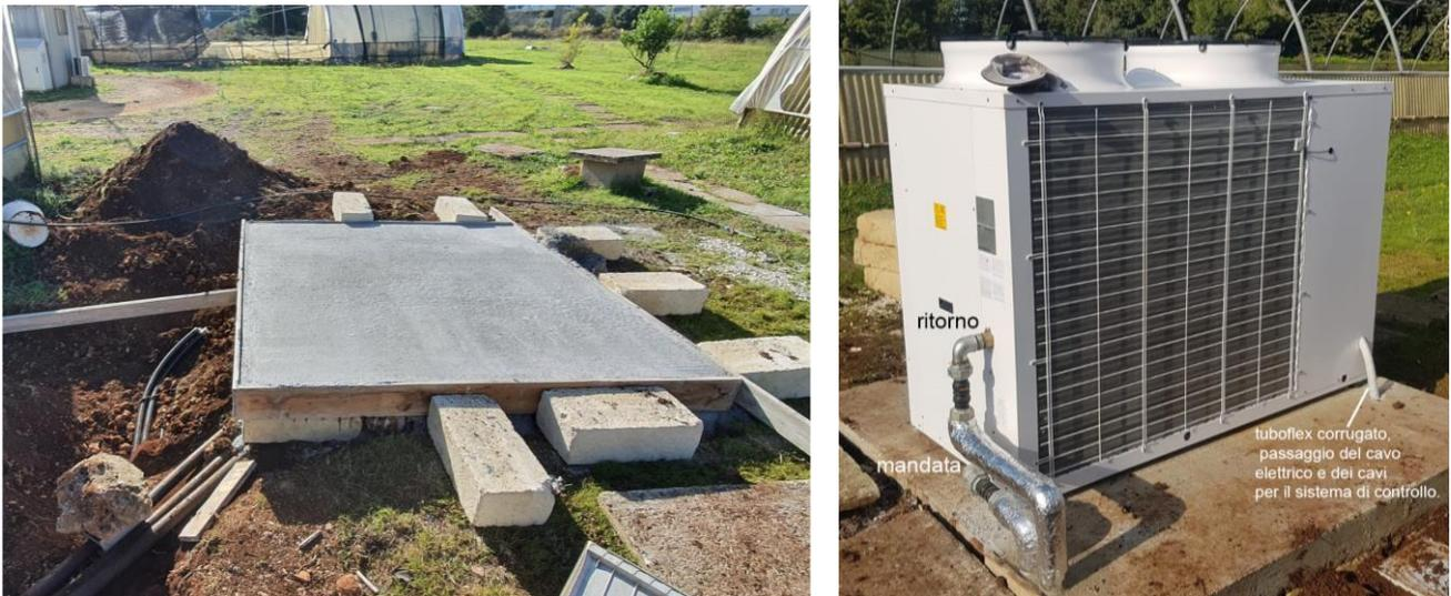
Figura 102. La pompa di calore AERMEC ANLI\_HX\_HP e il basamento in cemento sul quale è stata ancorata
