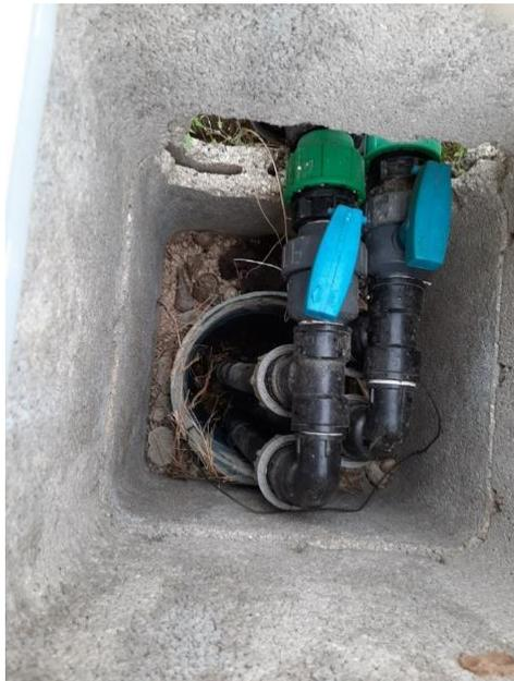
**Figura 94. Tubi della sonda geotermica in ingresso nel terreno**
