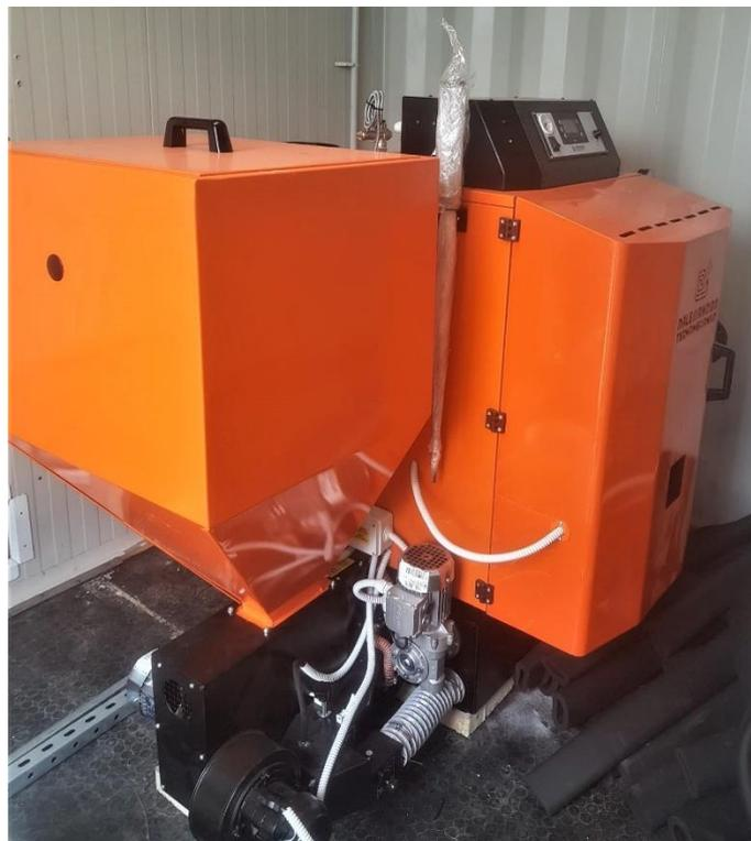
Figura 79. La caldaia a biomassa CS 30 installata all'interno del container
