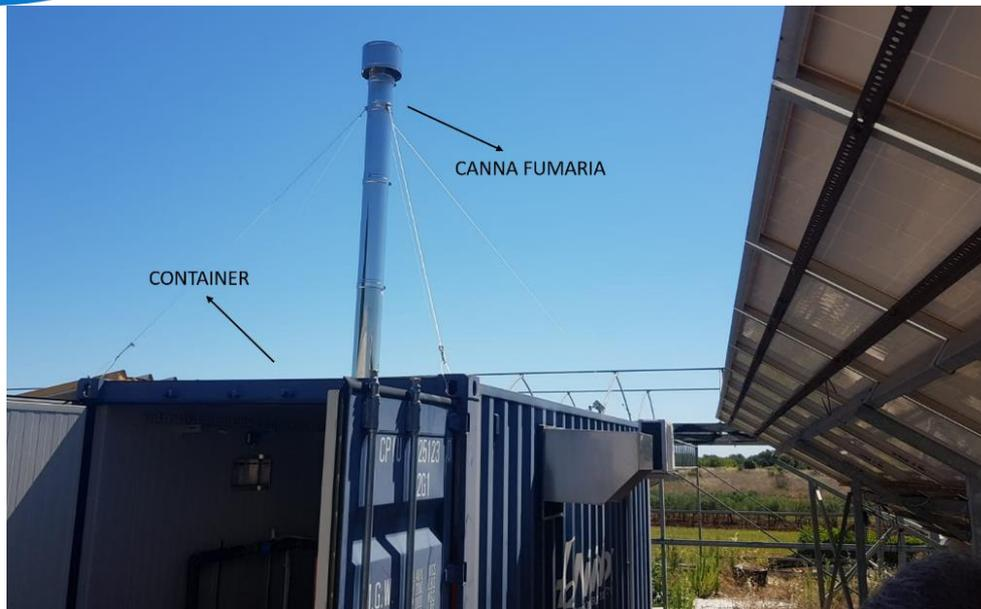
**Figura 80. Il container della caldaia a biomassa CS 30**
