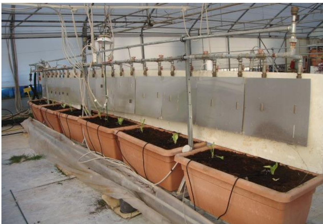
Figura 24. Sistema di distribuzione del freddo/caldo denominato “piastra e tubo” costituito da tubi posizionati sopra i vasi di coltivazione a contatto con piastre di alluminio.
