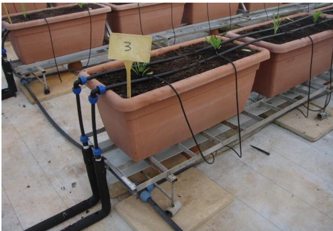
Figura 23. Sistema di distribuzione del freddo/caldo denominato “tubo poggiato”, realizzato con tubi poggiati sul substrato di coltivazione.
